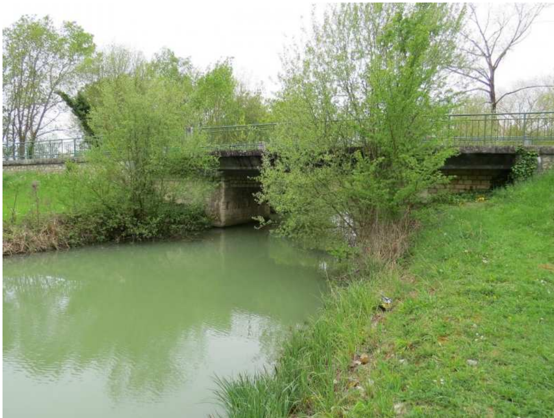
Figure 9:vue de l'ouvrage 54a depuis l'est
