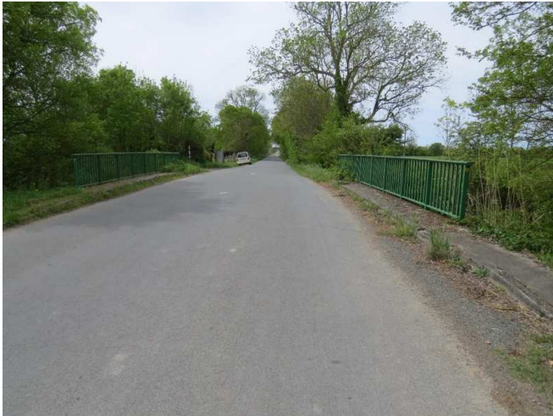
Figure 4:vue du franchissement depuis l'est
