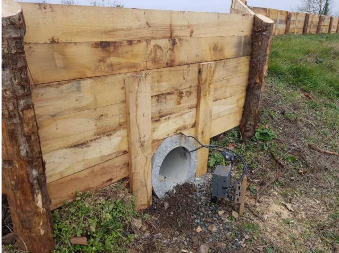
Figure 13:vue du raccord de l'entonnement à la tête de buse côté est
