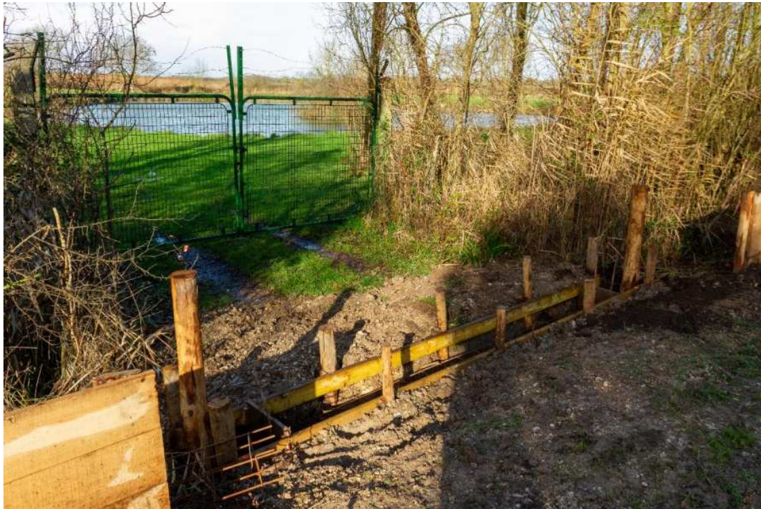
Figure 24: élaboration du coffrage
