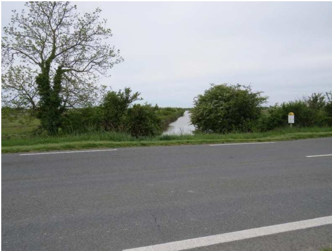
Figure 3:vue du franchissement et du canal de Suze depuis l'est
