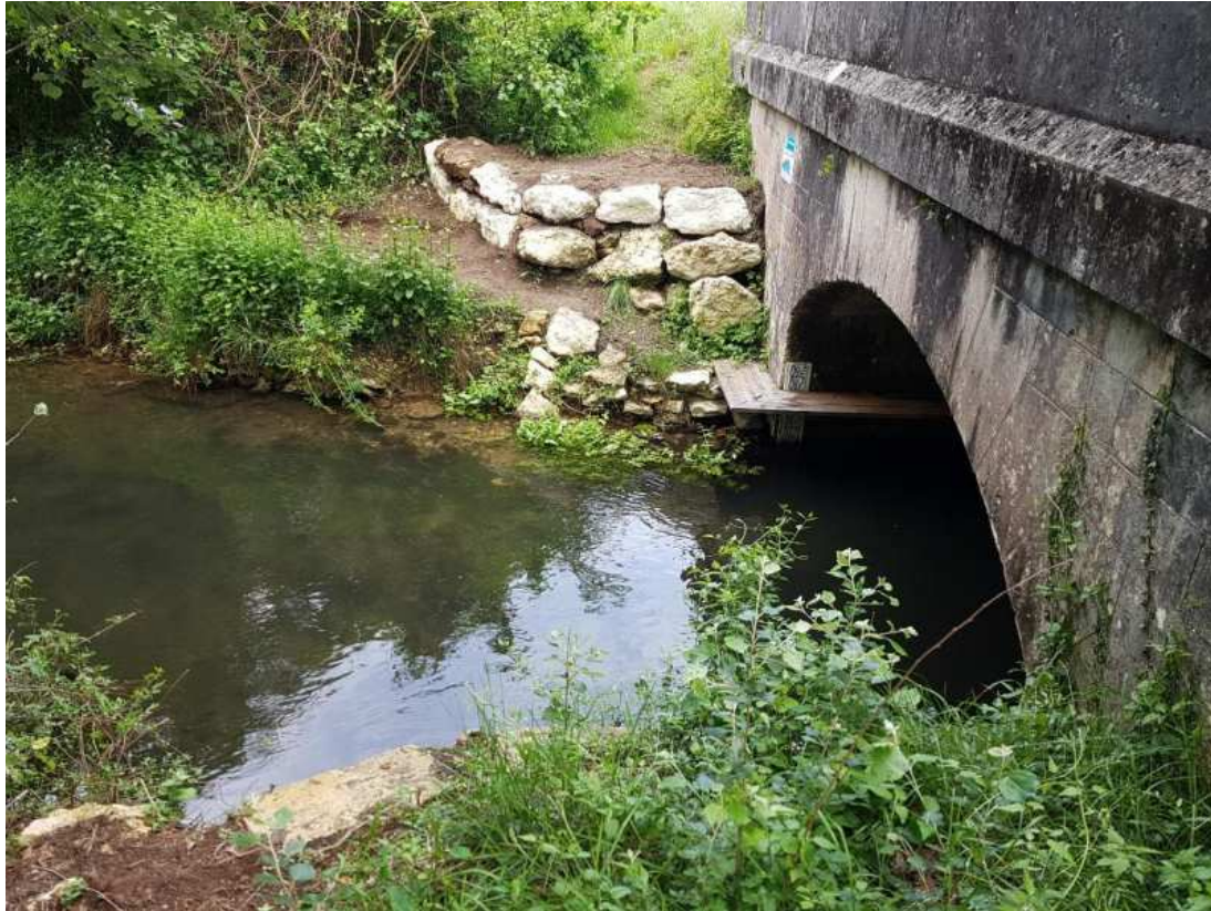
Figure 14:vue de la berge enrochée en amont de l'ouvrage 52
