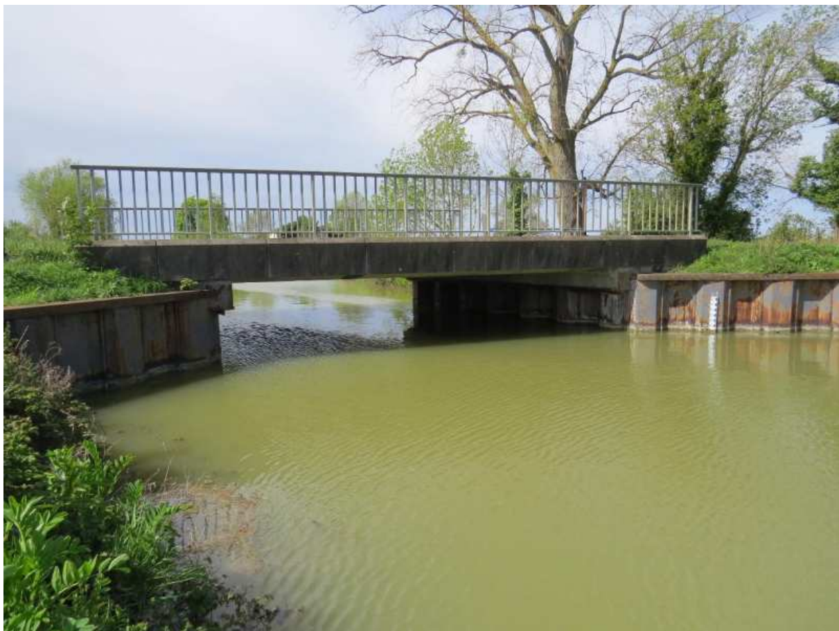
Figure 2:vue de l'ouvrage 58 depuis l'aval
