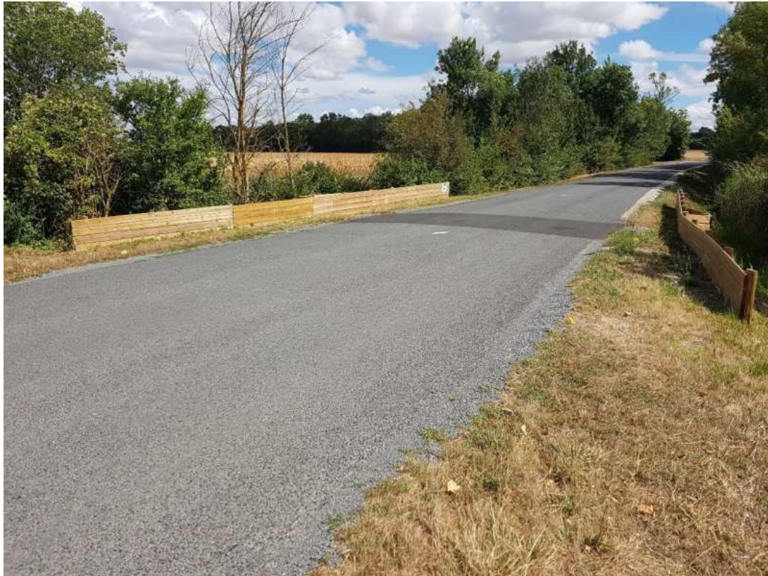
Figure 17:vue des palissades depuis le milieu du franchissement
