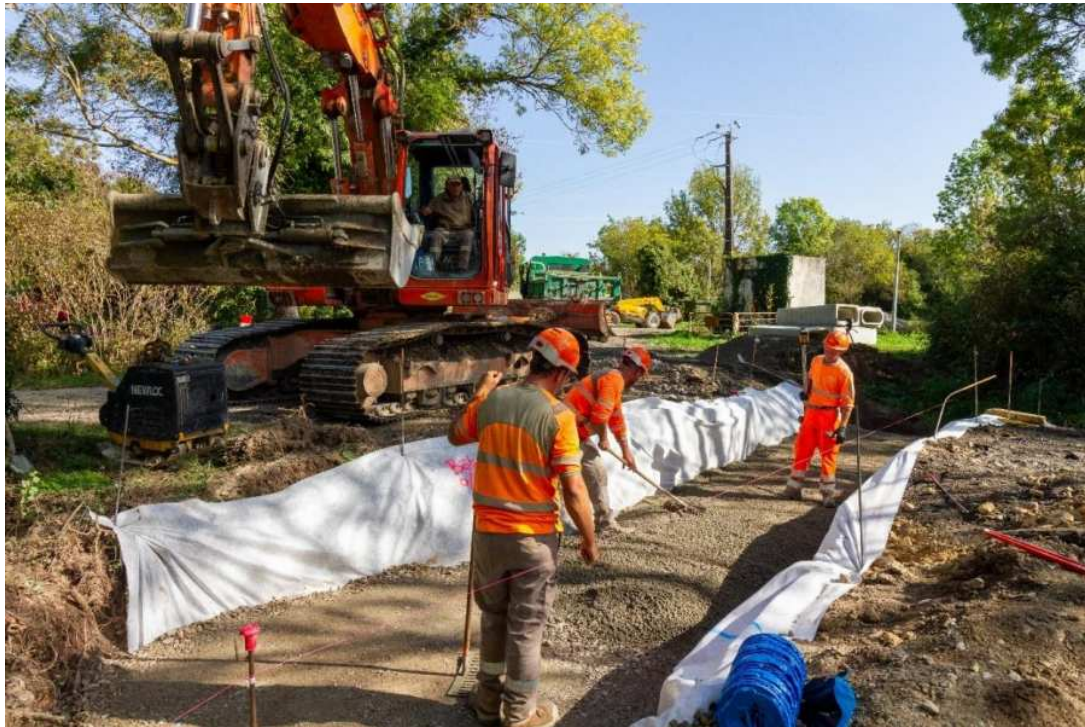
Figure 8: dépôt d'un lit de pierre
