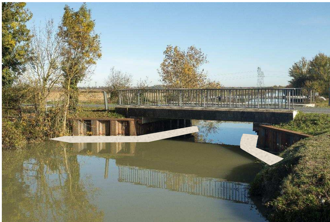
Figure 7:représentation des cheminements depuis l'amont de l'ouvrage 58
