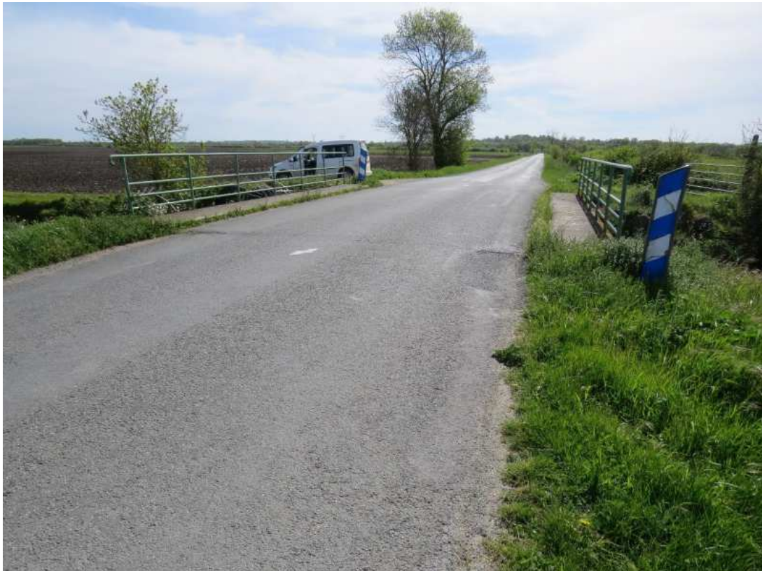
Figure 4:vue du franchissement depuis l'ouest
