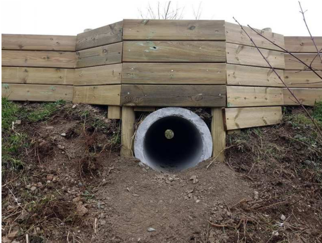
Figure 18:vue de l'entonnement des palissades en bout de buse
