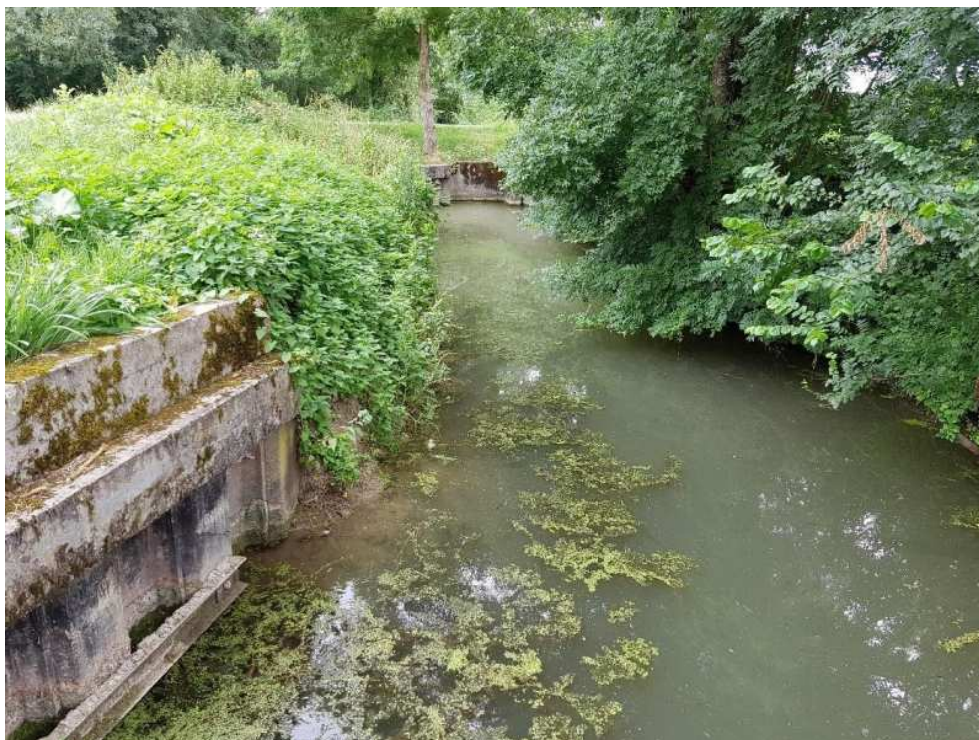
Figure 6:vue du canal de ceinture depuis l'ouest
