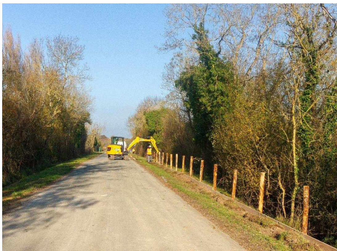
Figure 20: piquetage du tracé des palissades
