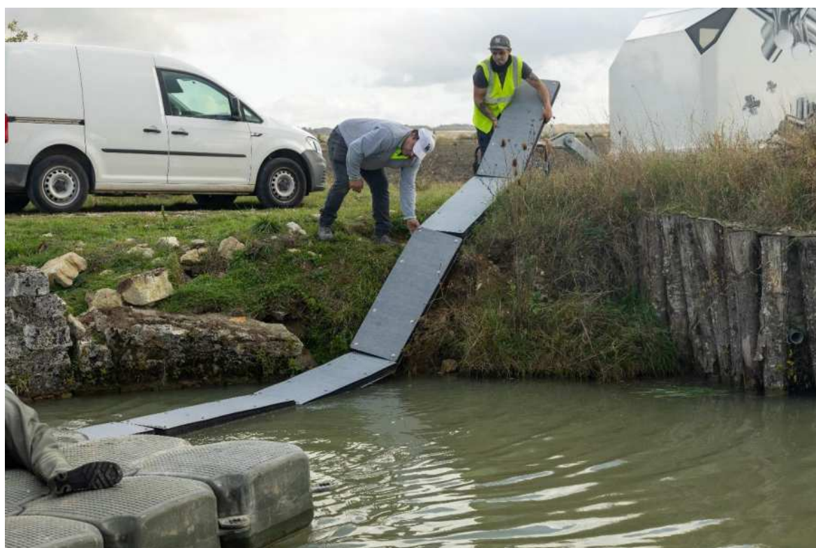
Figure 13: mise à l'eau des pontons
