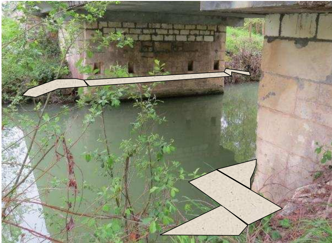
Figure 10:représentation des encorbellements de l'ouvrage 54a
