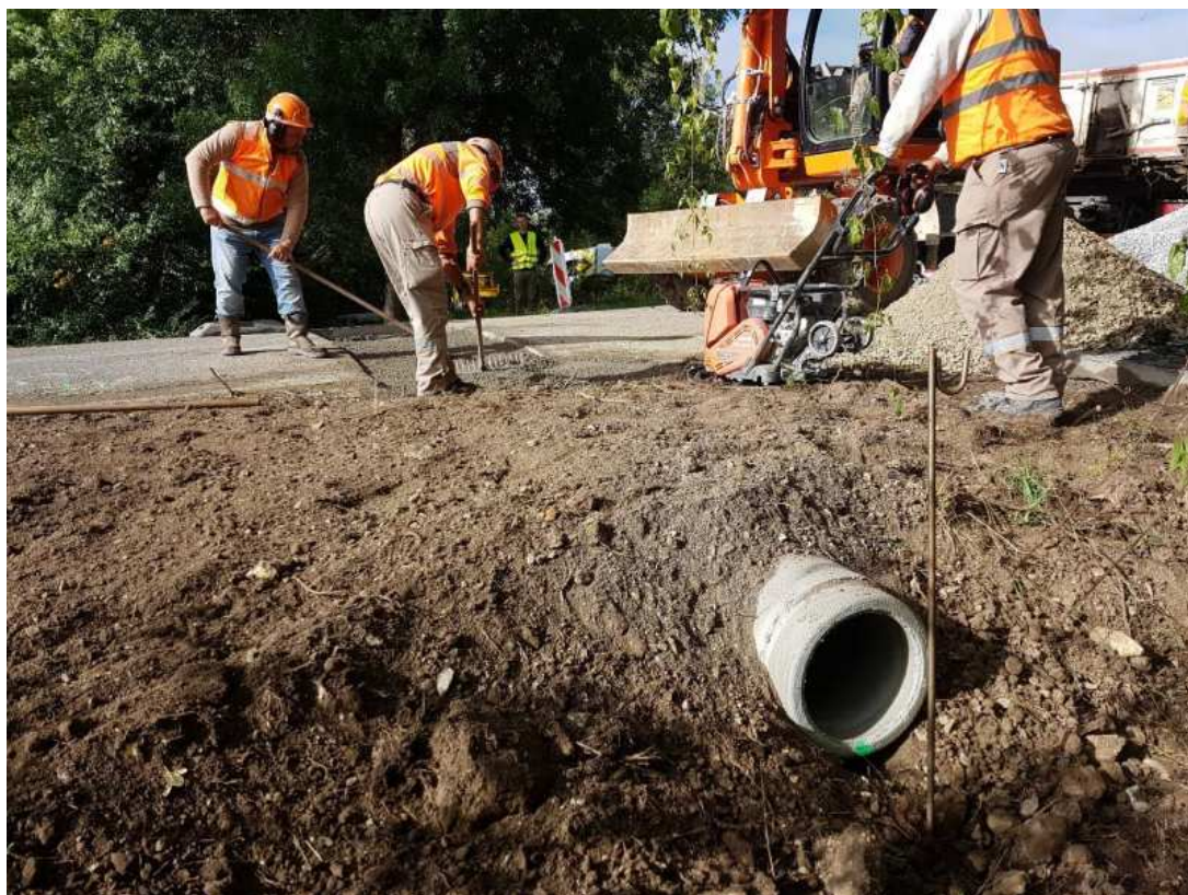
Figure 15:travaux d'installation de la buse de 300mm
