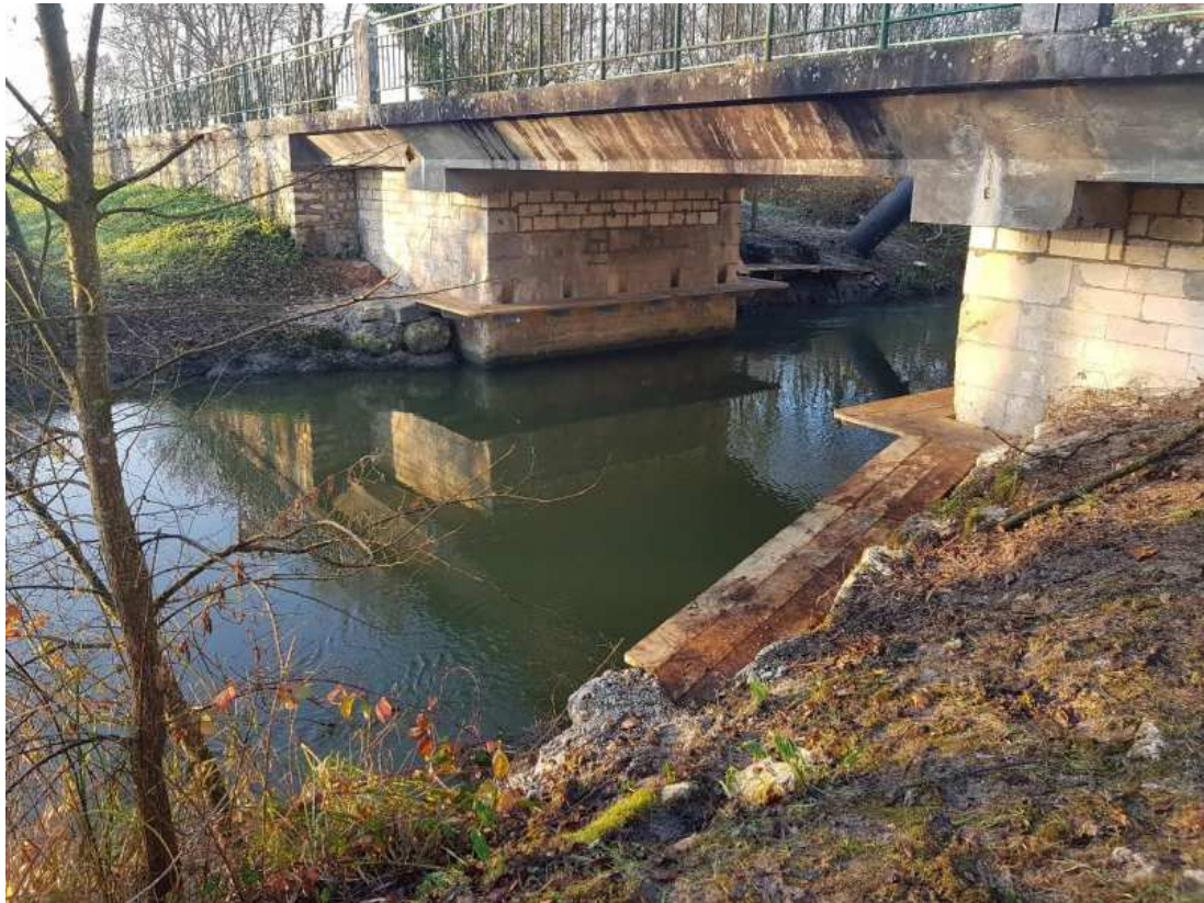
Figure 14:vue des encorbellements depuis l'amont de l'ouvrage 54a
