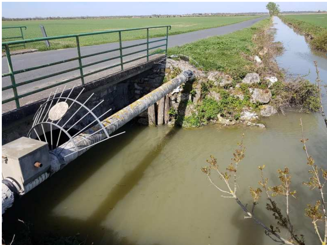
Figure 5:vue du franchissement depuis l'est
