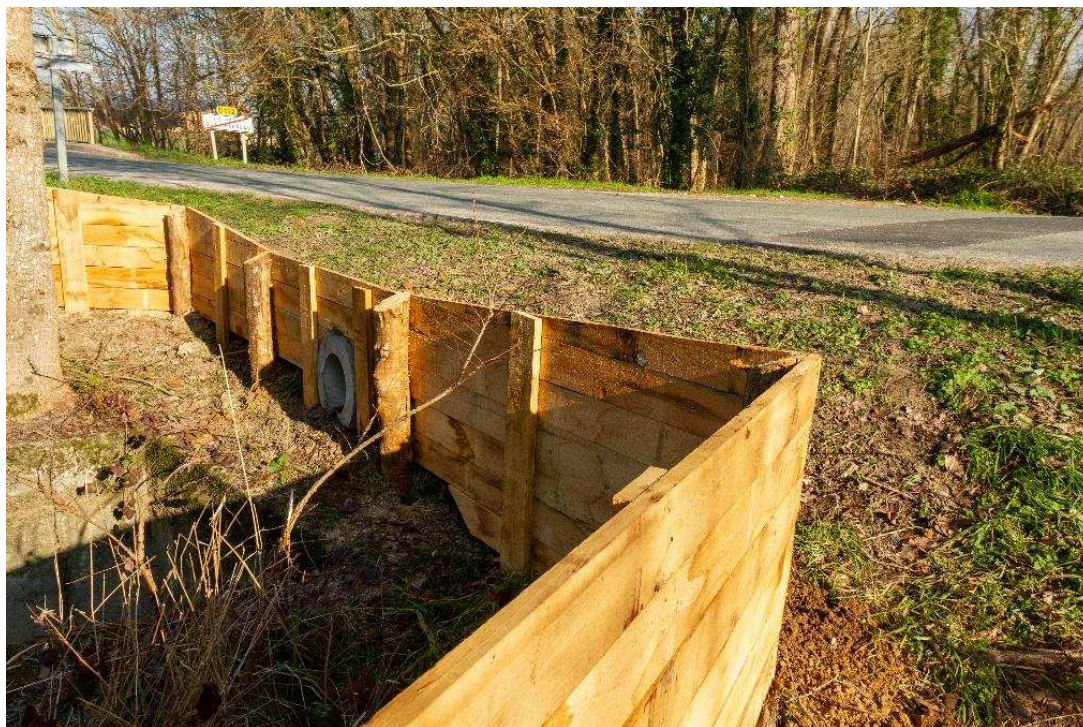
Figure 17:vue de la palissade sud du canal de ceinture
