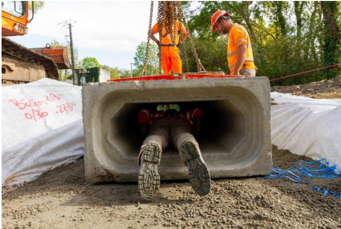
Figure 12:contrôle des jonctions
