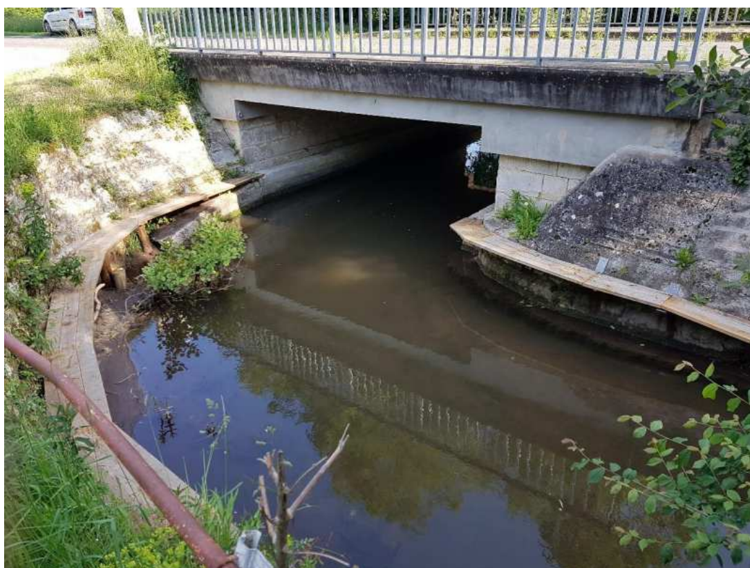
Figure 14:vue des encorbellements en amont de l'ouvrage 51
