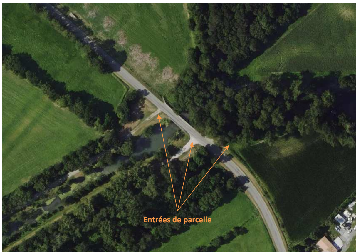
Figure 3: localisation des entrées de parcelle
