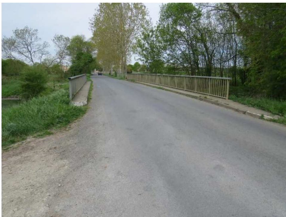
Figure 4:vue depuis le sud
