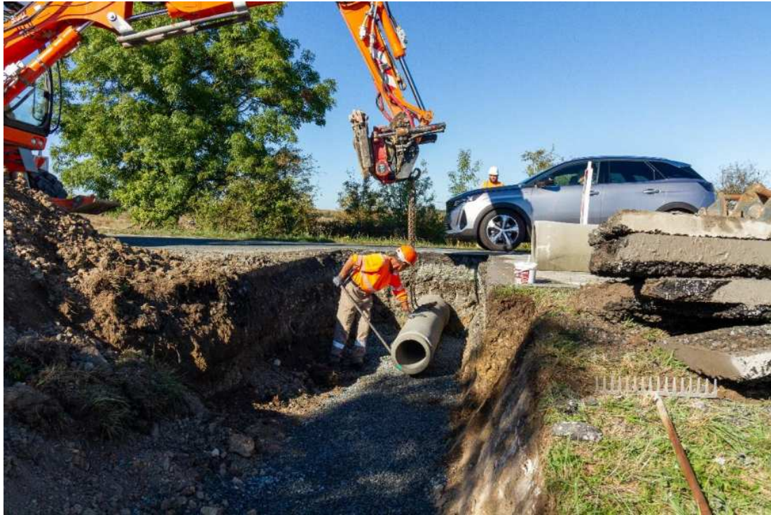
Figure 7: installation de la buse par travaux en demi-chaussée
