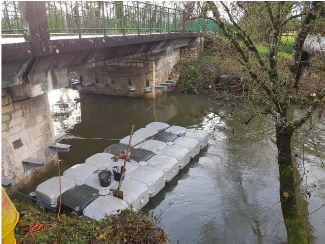
Figure 16: installation des encorbellements de l'ouvrage 54a
