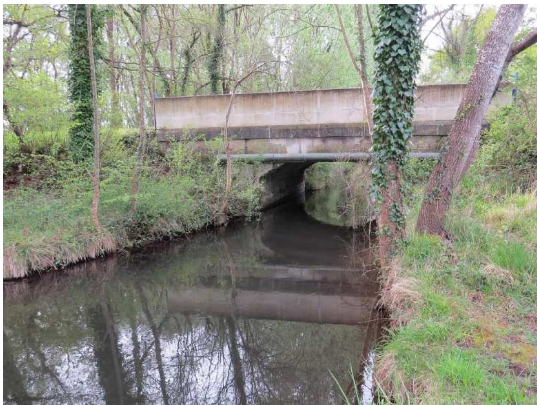
Figure 6:vue de l'ouvrage 52 depuis l'aval
