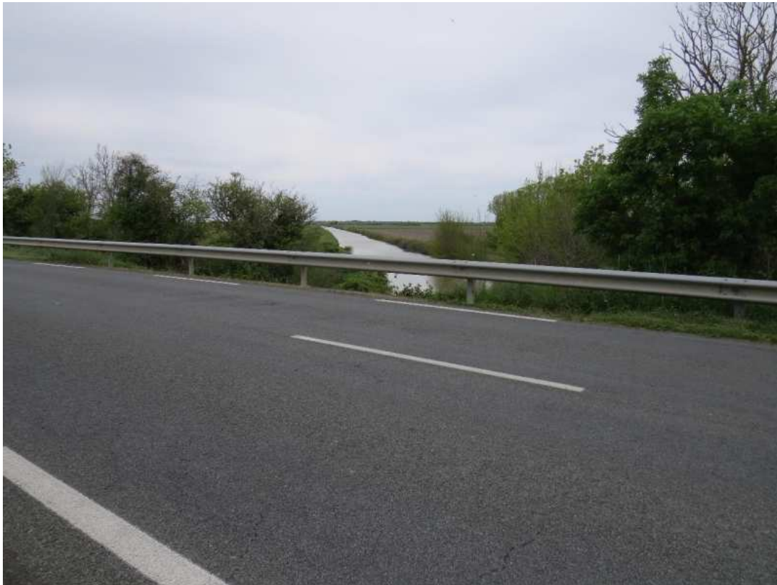
Figure 4:vue de la Levée de Moindreau depuis l'amont de l'ouvrage 56
