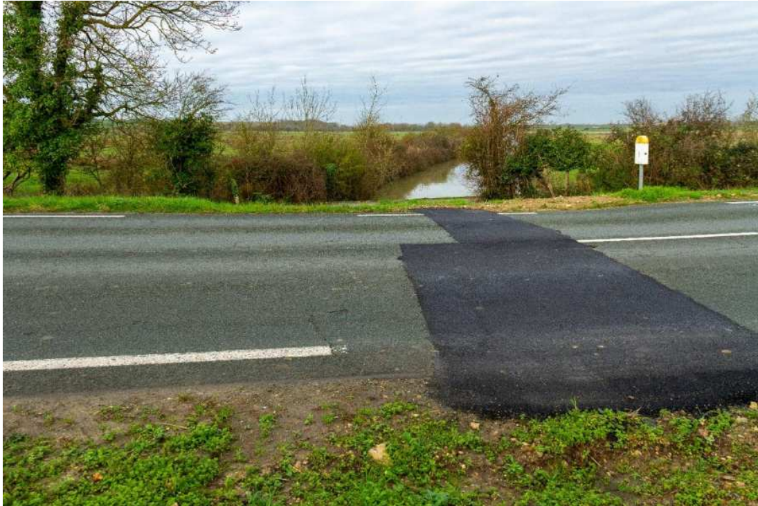
Figure 10:vue du chantier terminé et du canal de Suze depuis l'est
