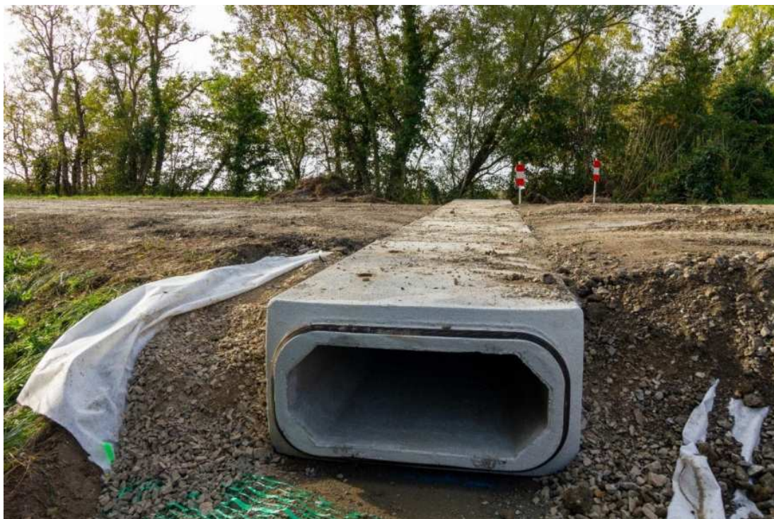
Figure 13:comblement de la tranchée
