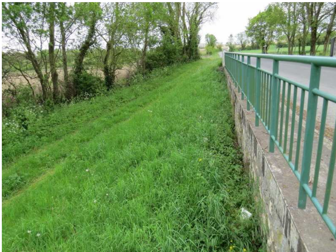
Figure 8:vue de l'entrée de parcelle sud-est
