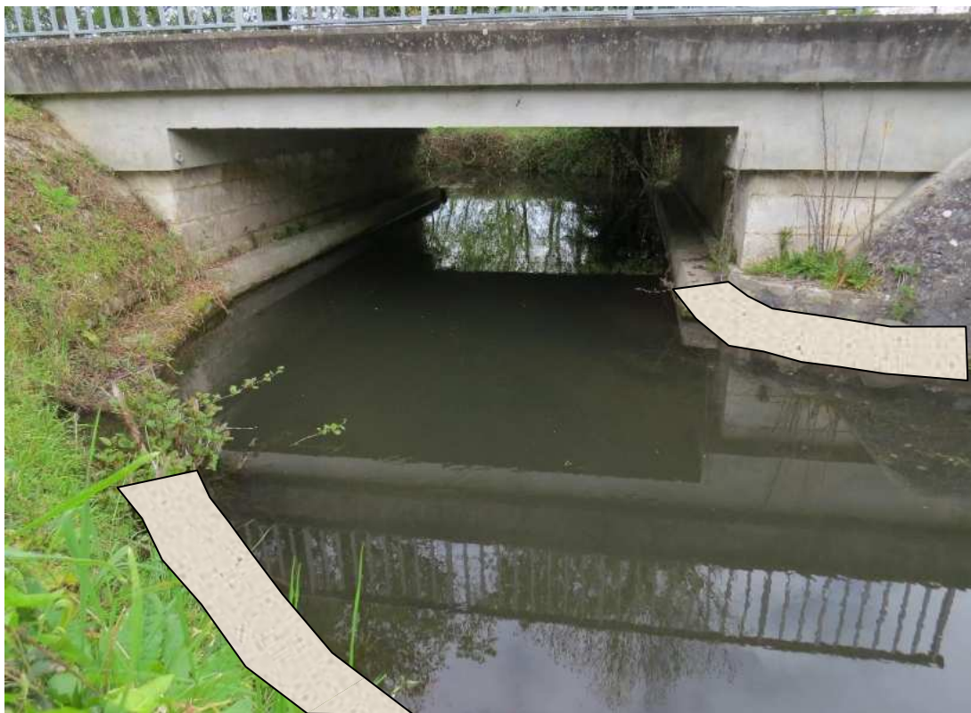
Figure 8:représentation des raccords en amont de l'ouvrage 51
