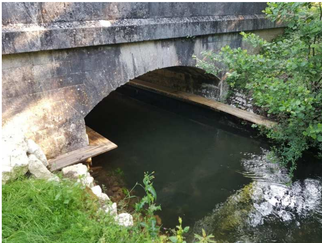
Figure 11:vue des encorbellements depuis l'amont de l'ouvrage 52
