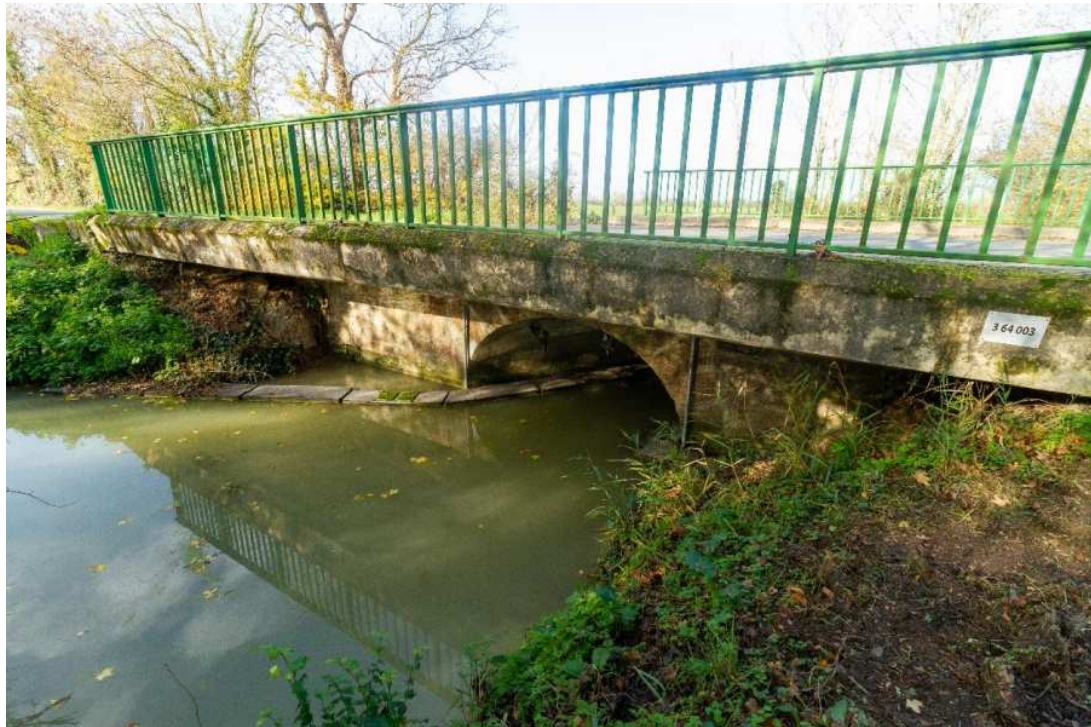
Figure 7:vue des pontons flottants depuis l'aval de l'ouvrage 50
