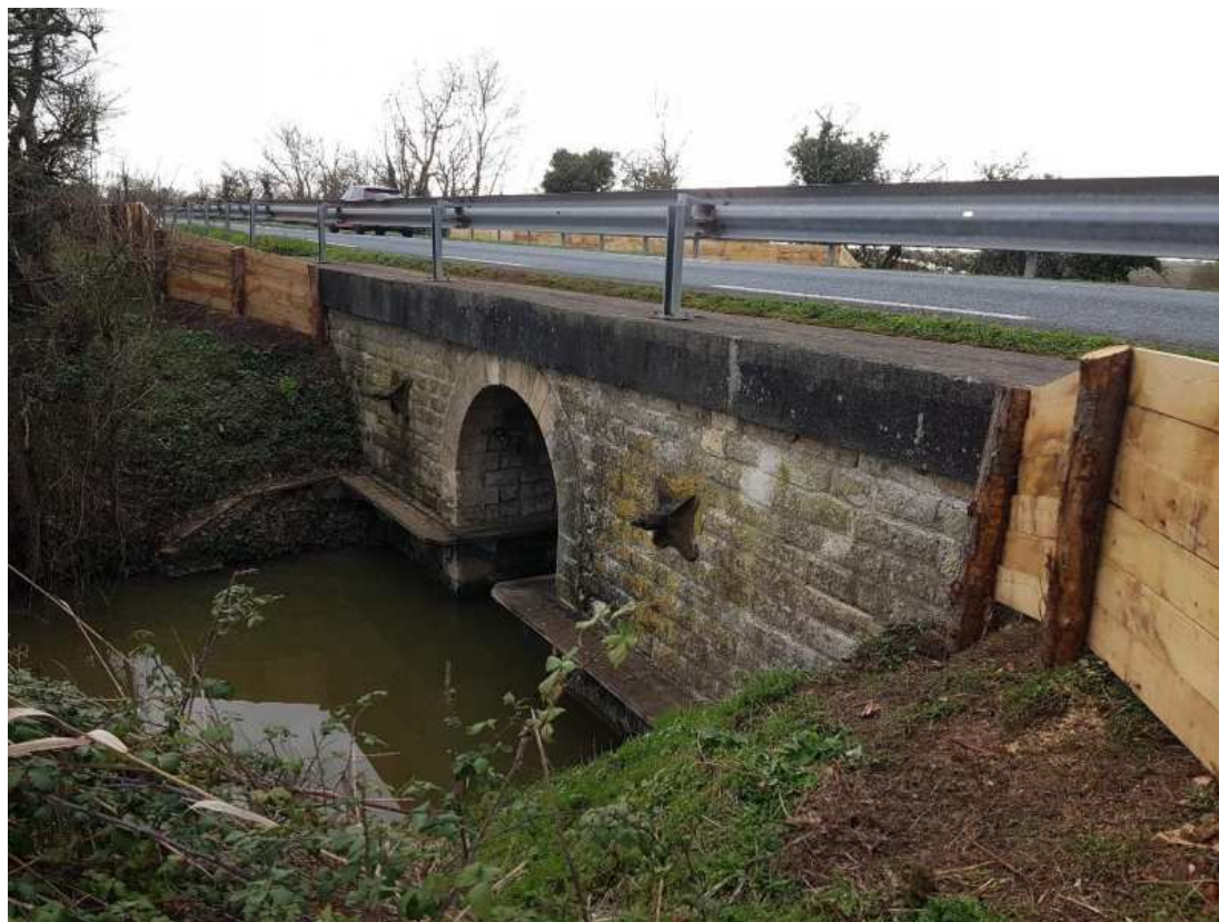
Figure 11:vue des palissades depuis l'amont de l'ouvrage 56
