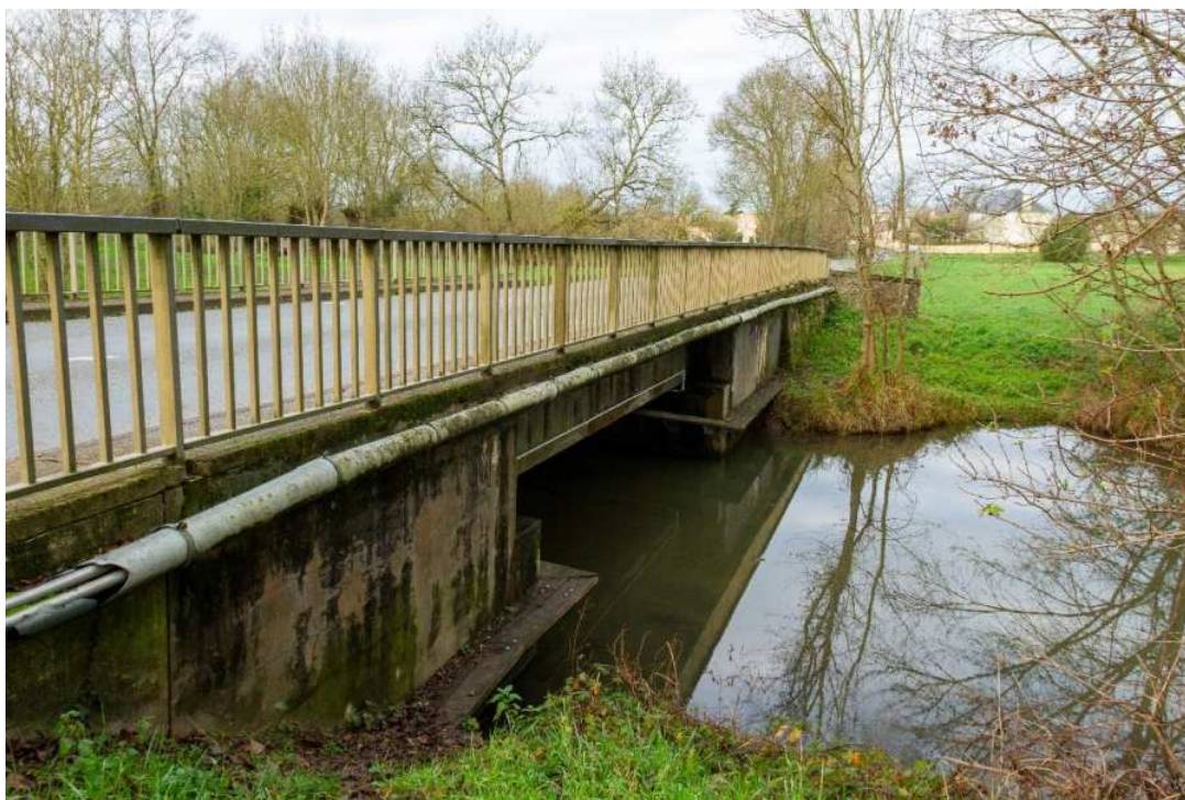
Figure 13:vue des encorbellements depuis l'amont de l'ouvrage 57
