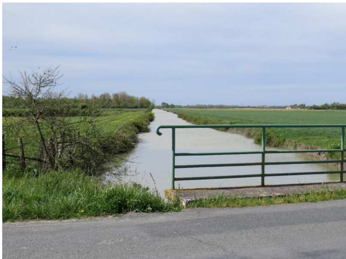
Figure 7:vue de l'amont du canal de Saint Louis depuis l'ouvrage 61
