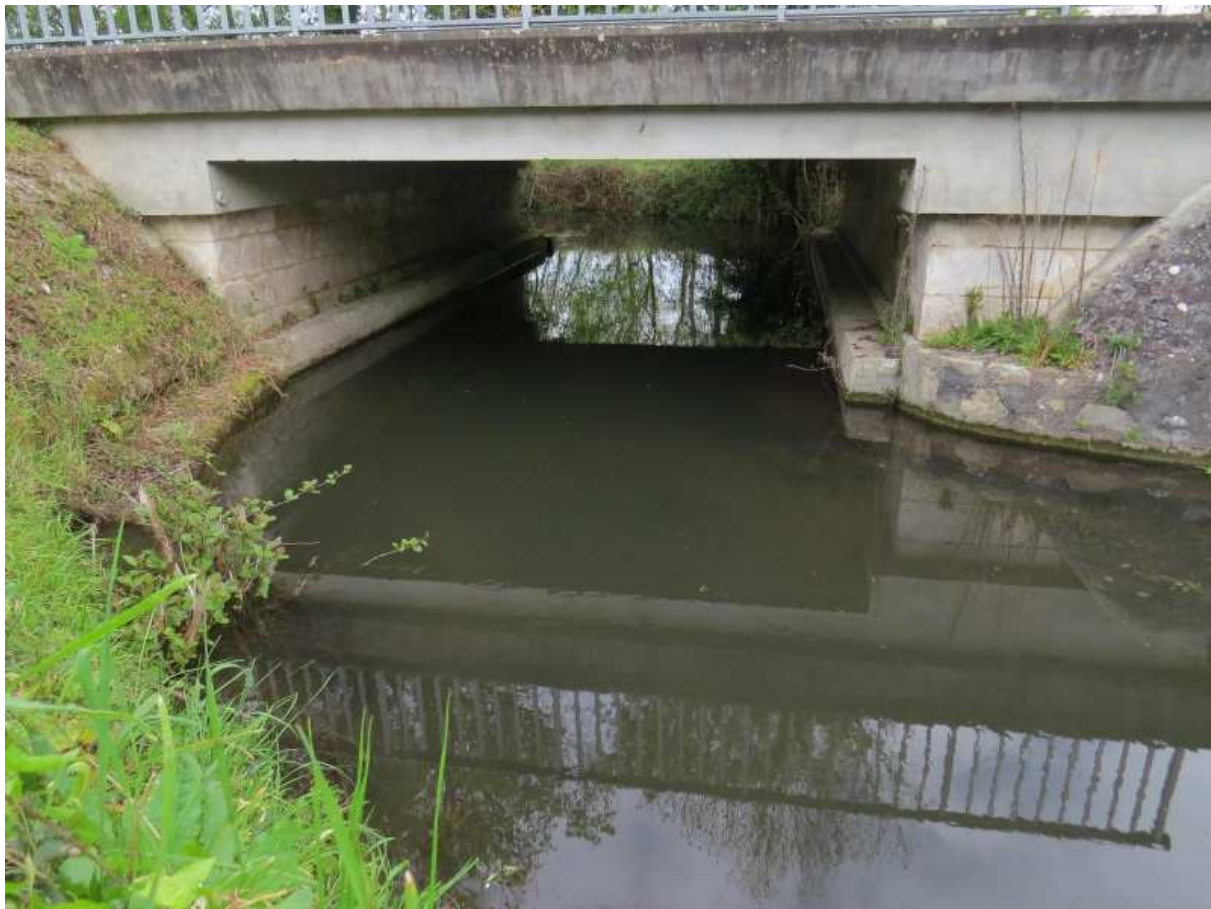
Figure 1:vue de l'ouvrage 51 depuis l'amont
