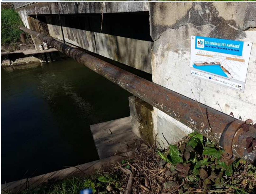
Figure 14:vue des encorbellements depuis l'aval de l'ouvrage 57
