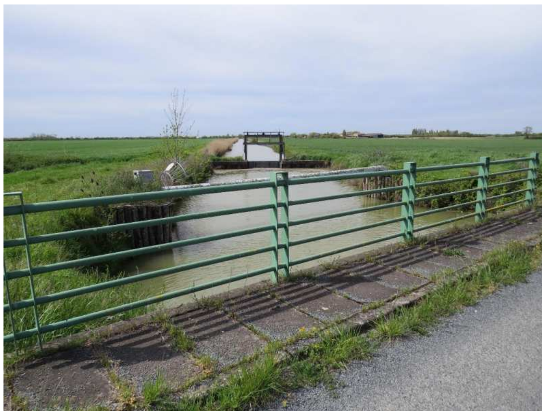
Figure 5:vue de la partie sud-ouest depuis l'ouvrage 60
