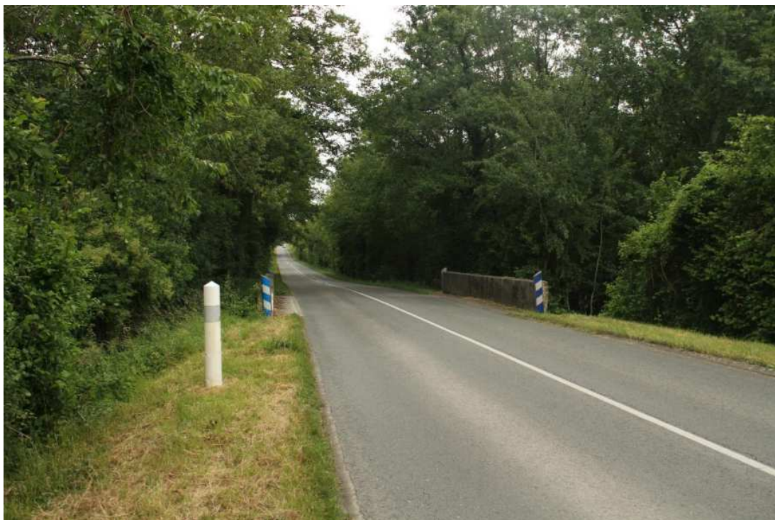
Figure 3:vue du franchissement depuis l'ouest
