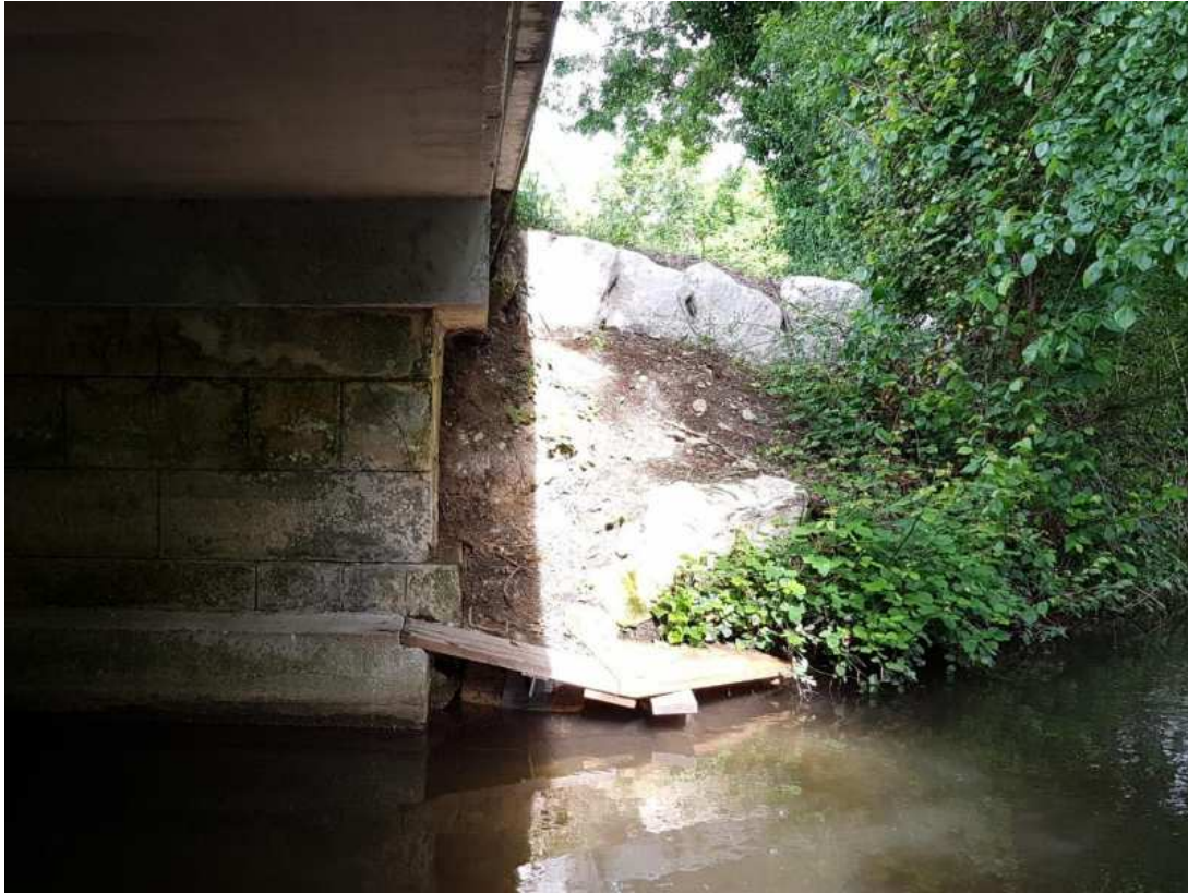
Figure 15:vue de l'encorbellement en aval de l'ouvrage 51 rive gauche
