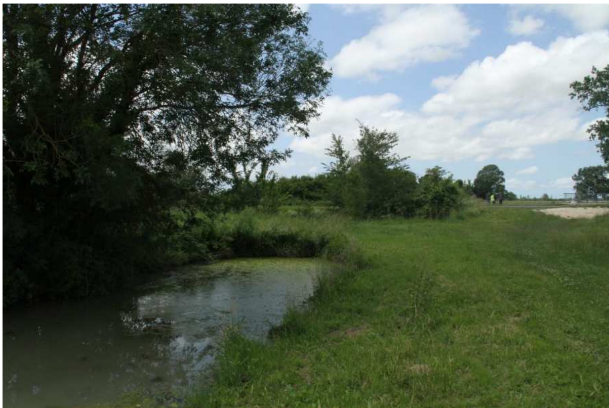
Figure 6:vue du franchissement depuis le canal des Treize prises
