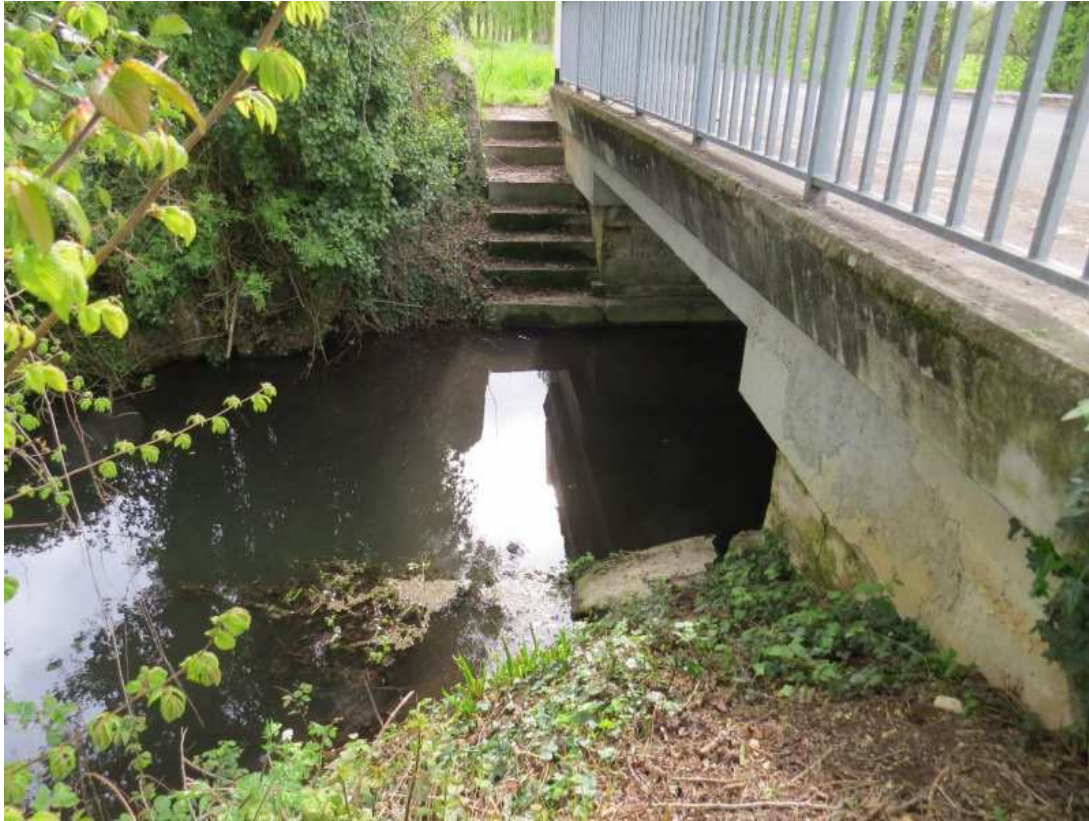
Figure 5:vue de l'ouvrage 51 et de l'escalier depuis l'aval
