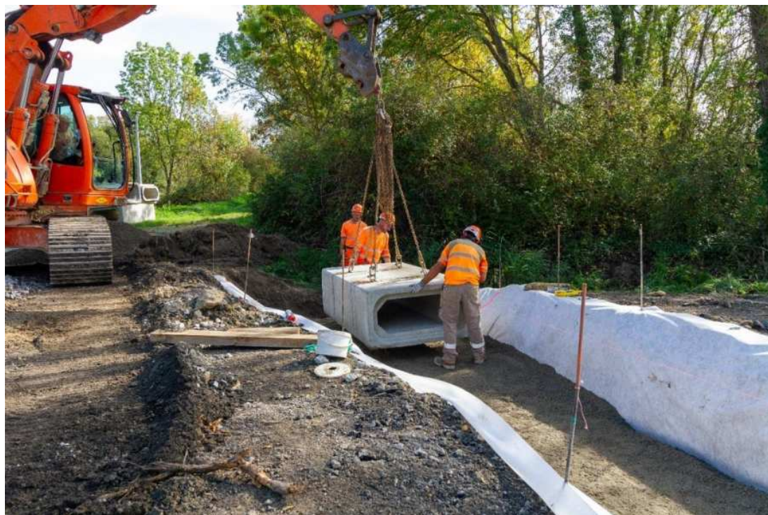
Figure 10: installation d'un élément
