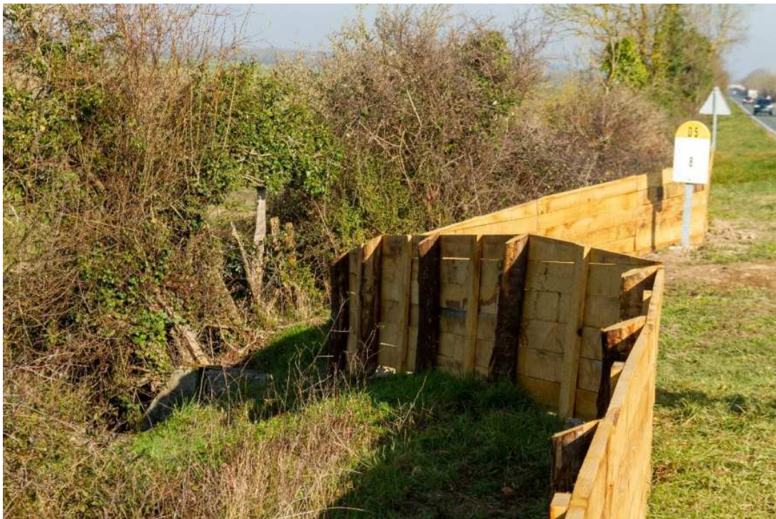
Figure 12: vue de l'entonnement côté ouest du franchissement
