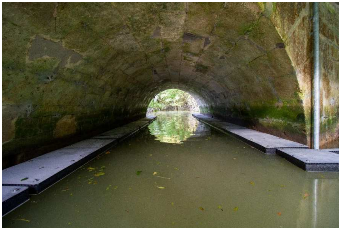
Figure 9:vue des pontons flottants depuis l'intérieur de l'ouvrage 50
