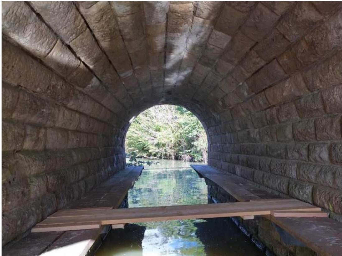
Figure 9:vue de la planche amovible de connexion des berges depuis l'intérieur de l'ouvrage 56
