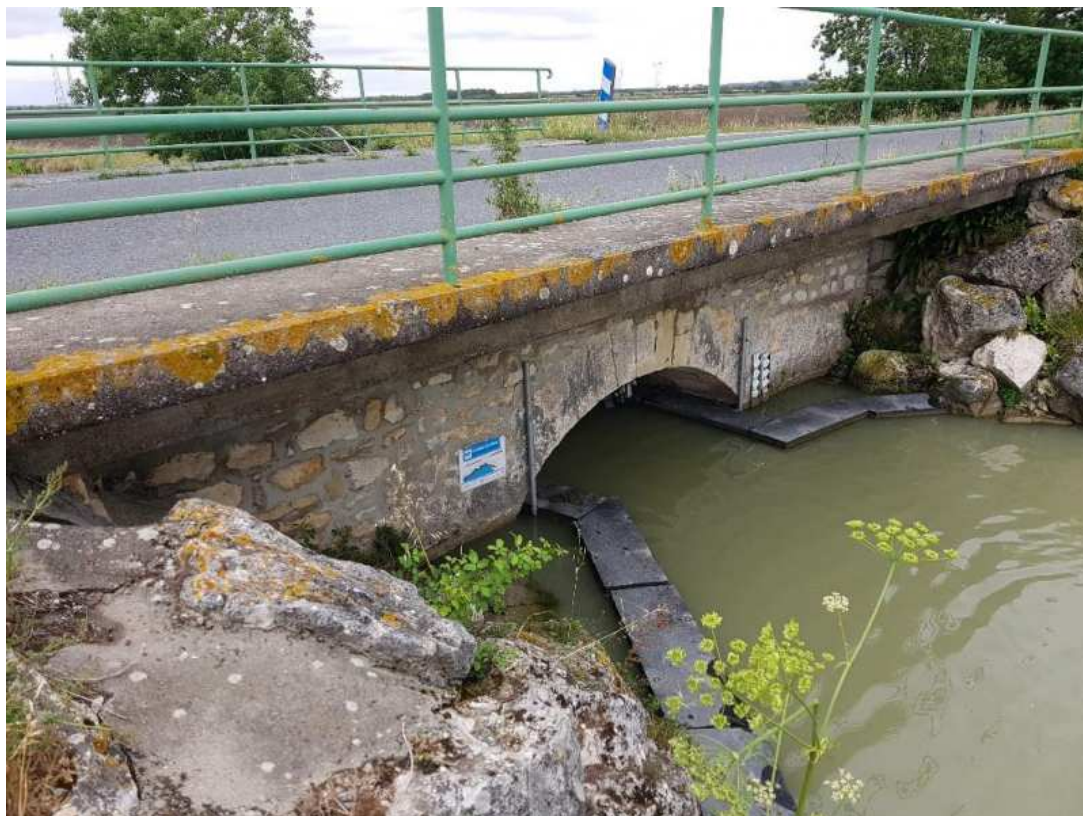
Figure 10:vue des pontons flottants depuis l'amont de l'ouvrage 61
