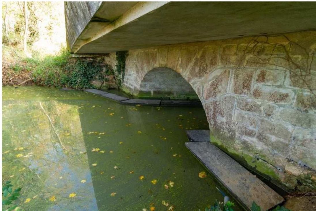
Figure 8:vue des pontons flottants depuis l'amont de l'ouvrage 50
