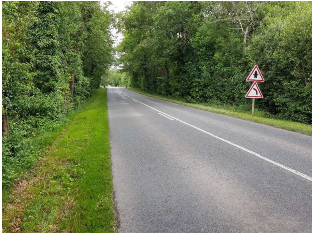
Figure 4:vue du franchissement depuis l'est
