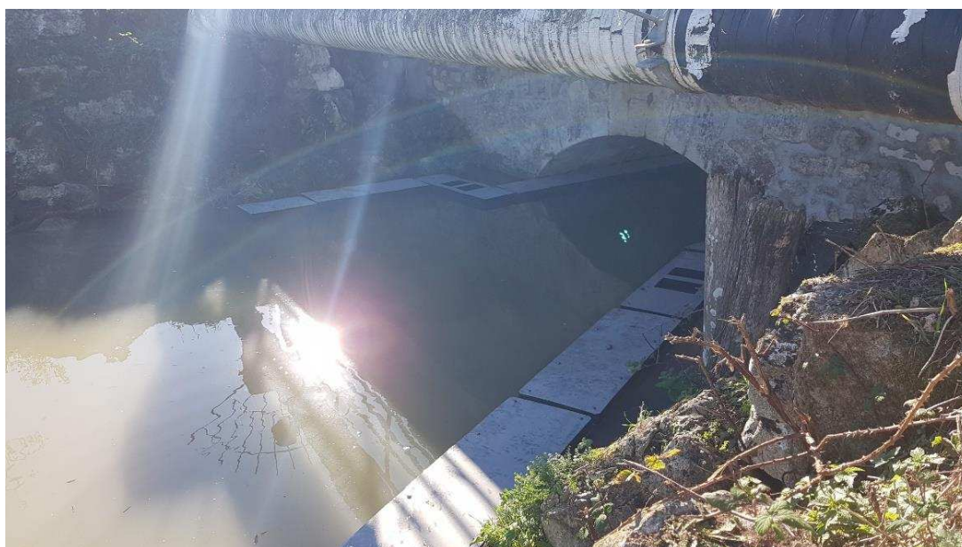
Figure 11:vue des pontons flottants depuis l'aval de l'ouvrage 61
