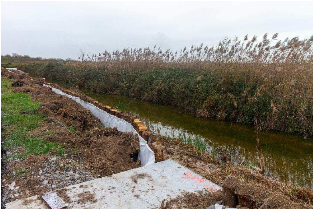
Figure 18: installation grillage anti-fouisseurs et géotextile
