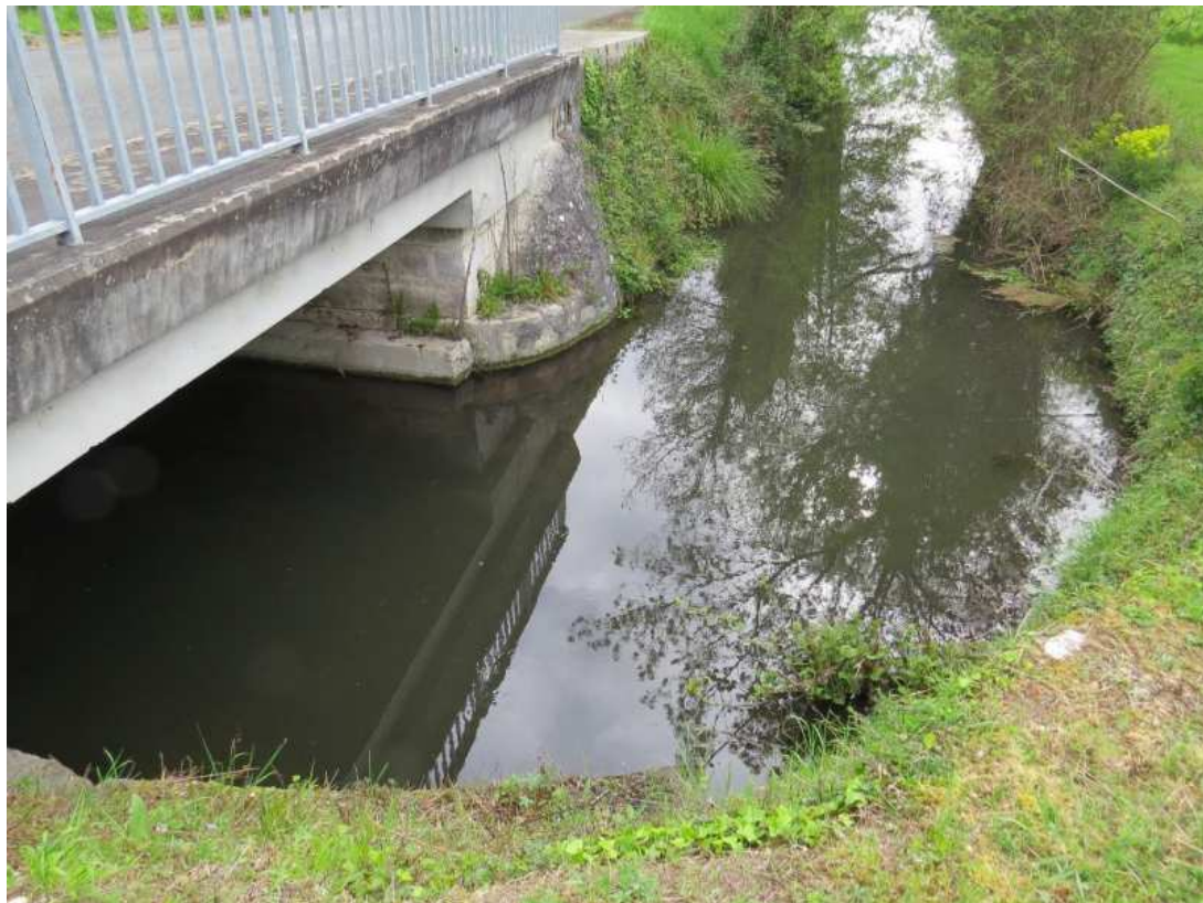
Figure 4:vue de l'ouvrage 51 depuis l'amont
