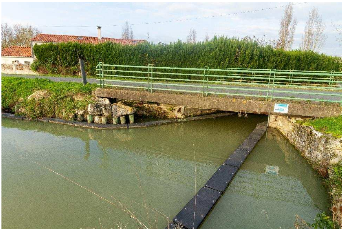
Figure 9:vue des pontons flottants depuis l'amont de l'ouvrage 60
