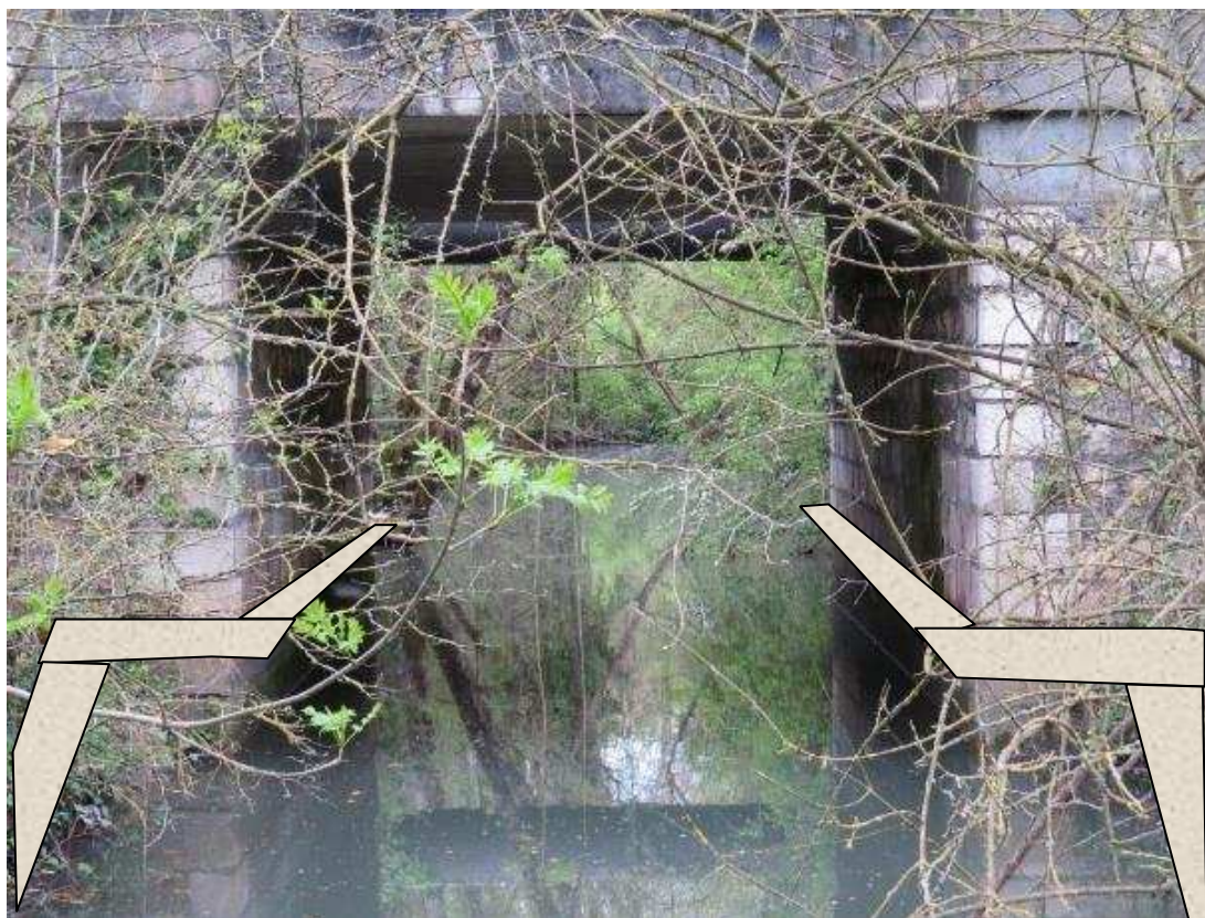
Figure 11:représentation des encorbellements de l'ouvrage 54b
