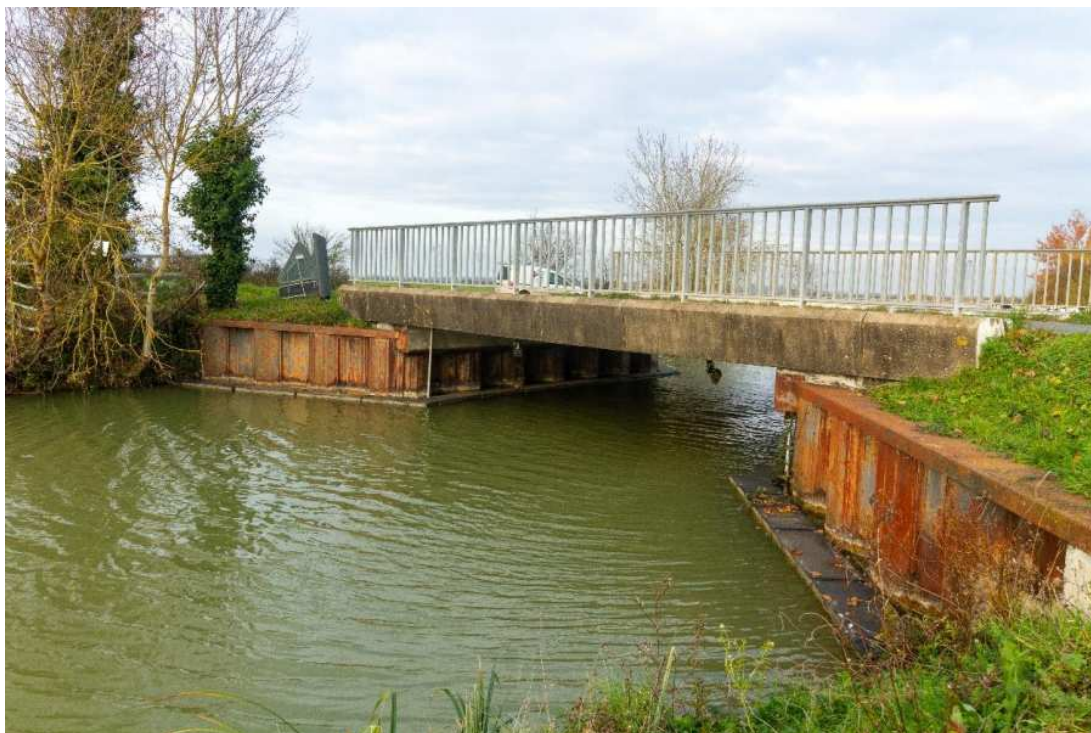
Figure 11:vue des pontons depuis l'amont de l'ouvrage 58
