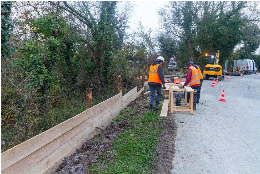
Figure 21: découpe et assemblage des palissades
