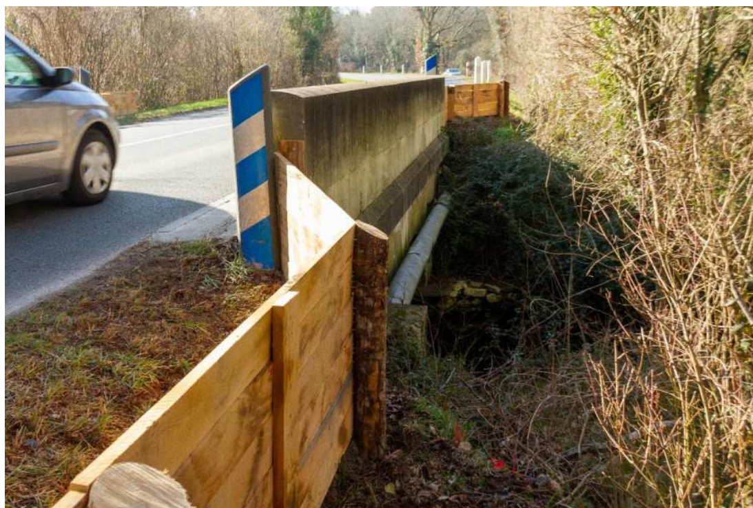
Figure 16: vue des palissades depuis l'est de l'ouvrage 52
