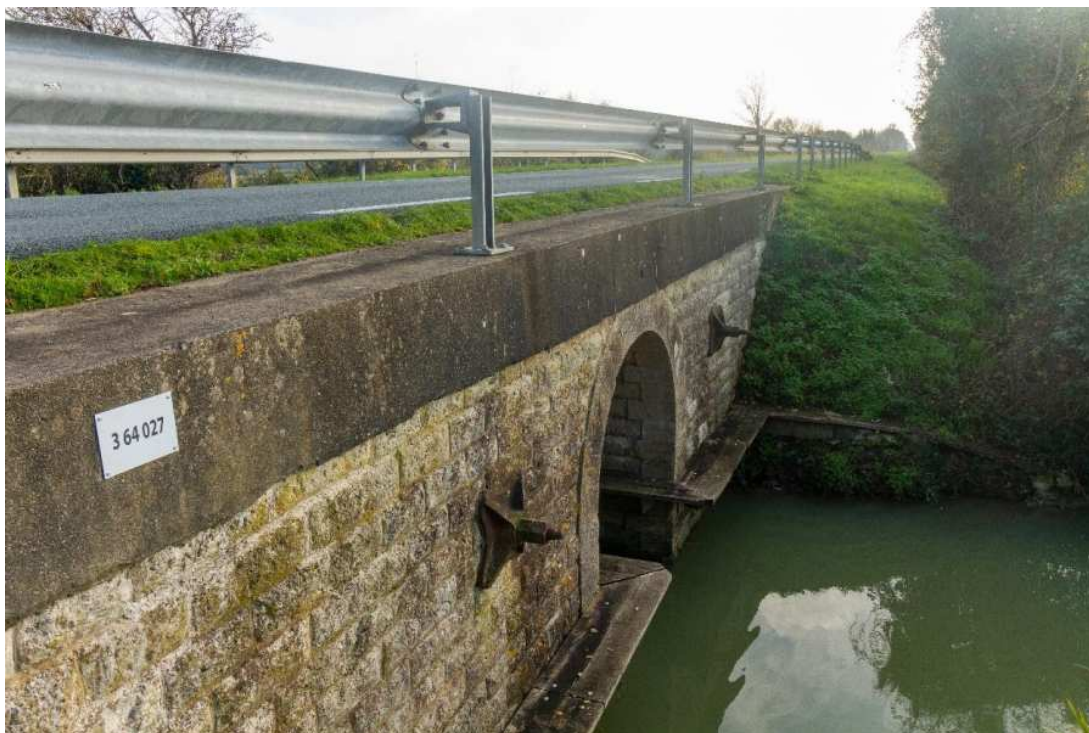
Figure 7:vue des encorbellements depuis l'amont de l'ouvrage 56
