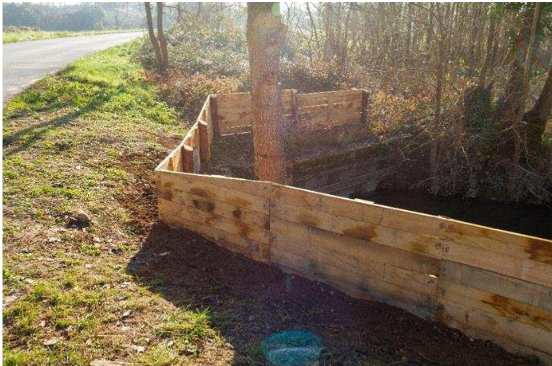
Figure 19:vue générale de l'entonnement sud du canal de ceinture
