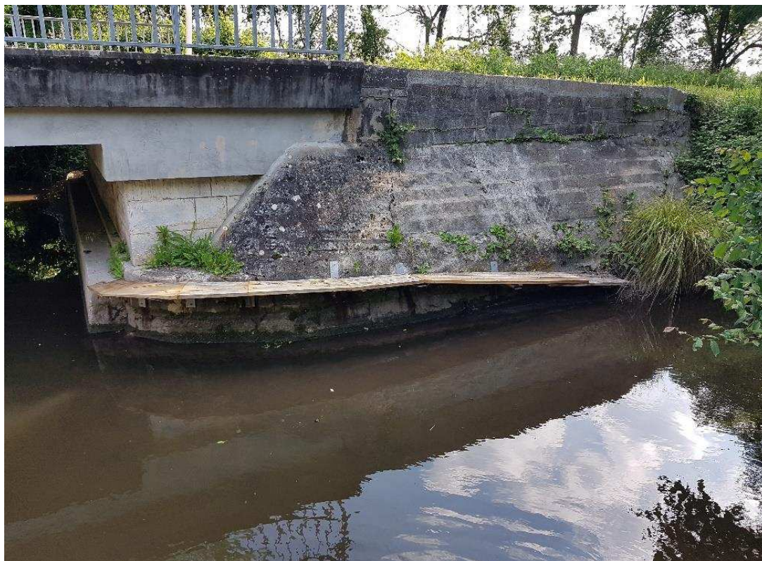
Figure 13:vue de l'encorbellement en amont de l'ouvrage 51 rive droite
