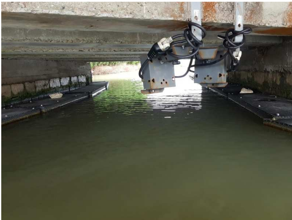
Figure 11:vue des pontons flottants depuis l'intérieur de l'ouvrage 60
