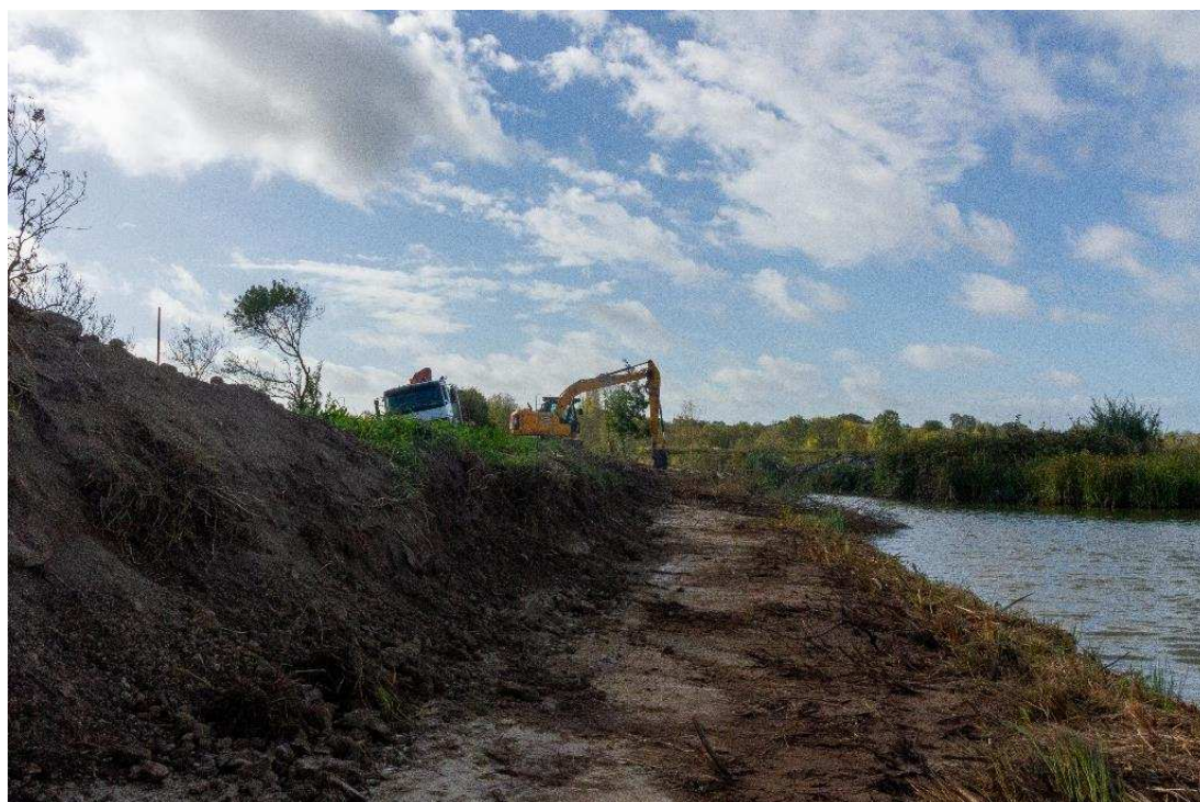
Figure 15:préparation des berges
