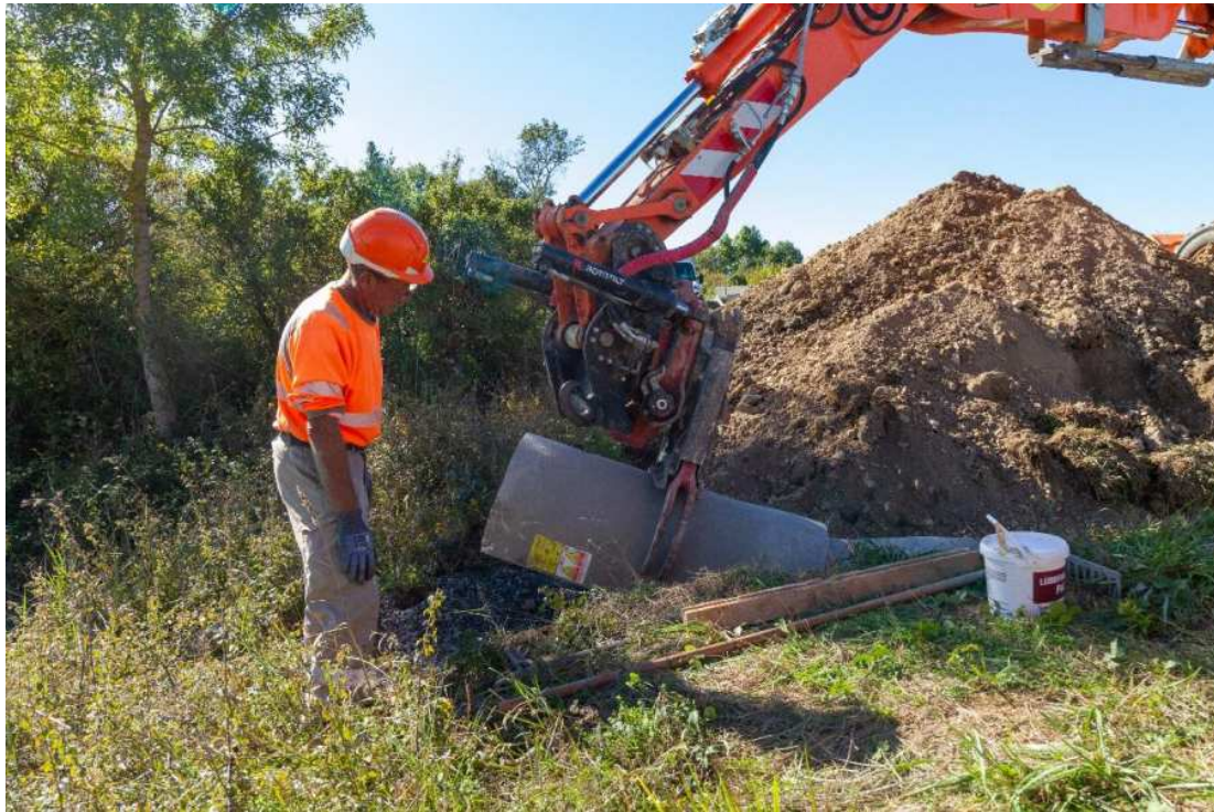
Figure 8: mise en place de la tête de buse
