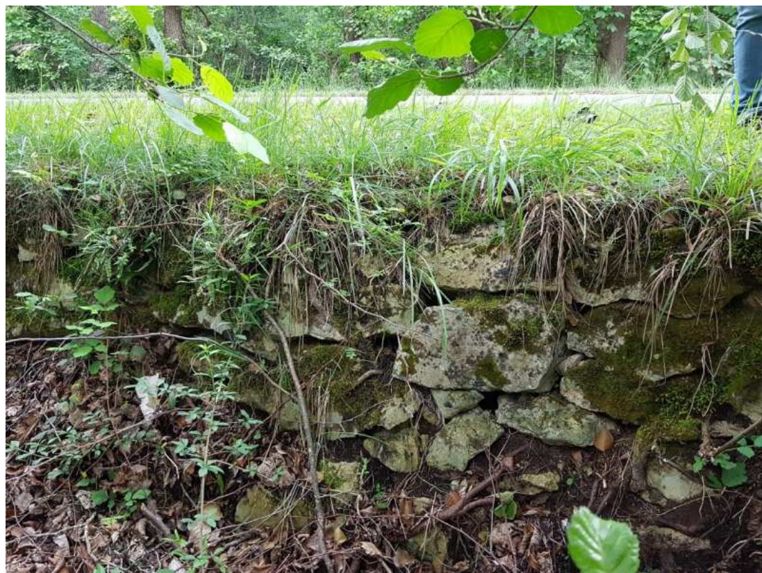
Figure 8:vue du soubassement de la route départementale
