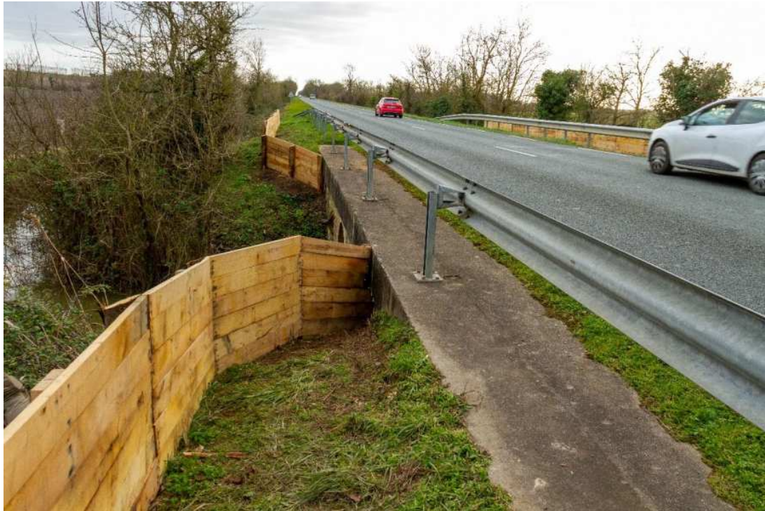
Figure 10:vue des palissades en amont de l'ouvrage 56
