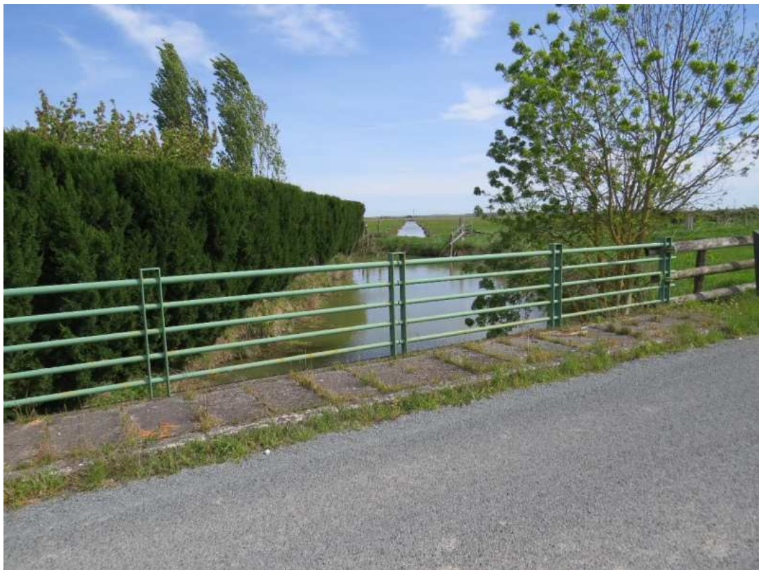
Figure 7:vue de la partie nord-est depuis l'ouvrage 60
