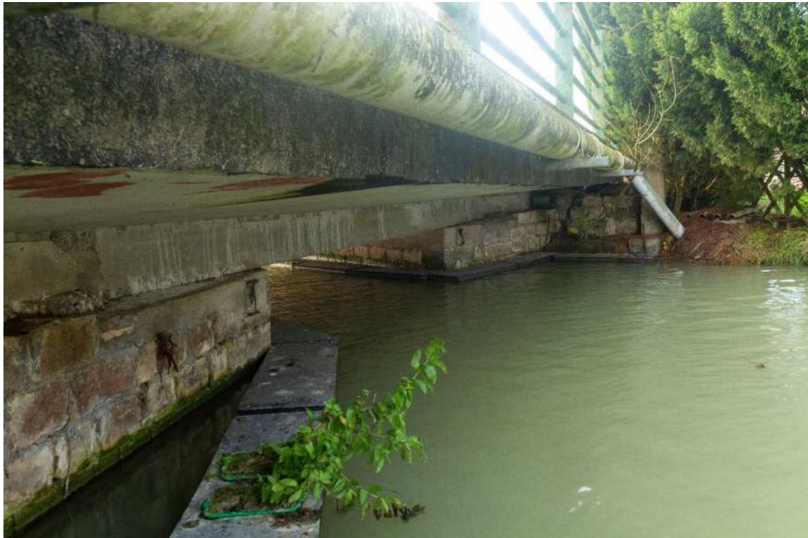
Figure 10:vue des pontons flottants depuis l'aval de l'ouvrage 60
