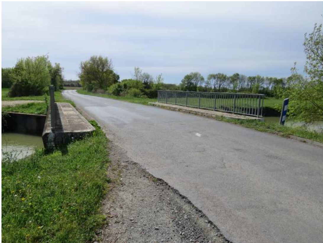
Figure 4:vue du franchissement depuis le nord
