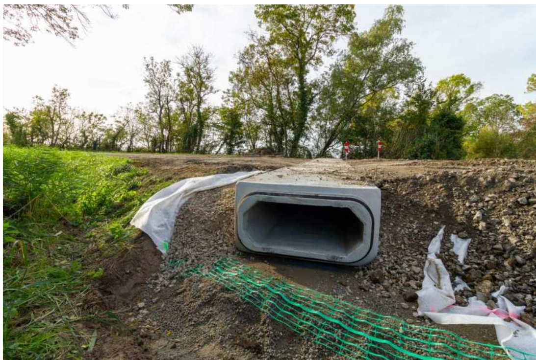
Figure 6: exemple de pose du dalot 5 entre la route et des réseaux enterrés
