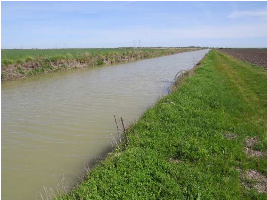
Figure 6:vue de l'aval du canal de Saint Louis depuis l'ouvrage 61
