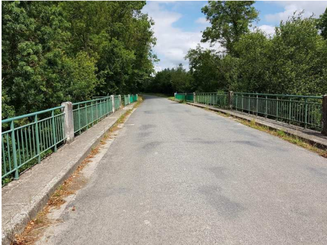
Figure 5:vue du franchissement 54 depuis le sud
