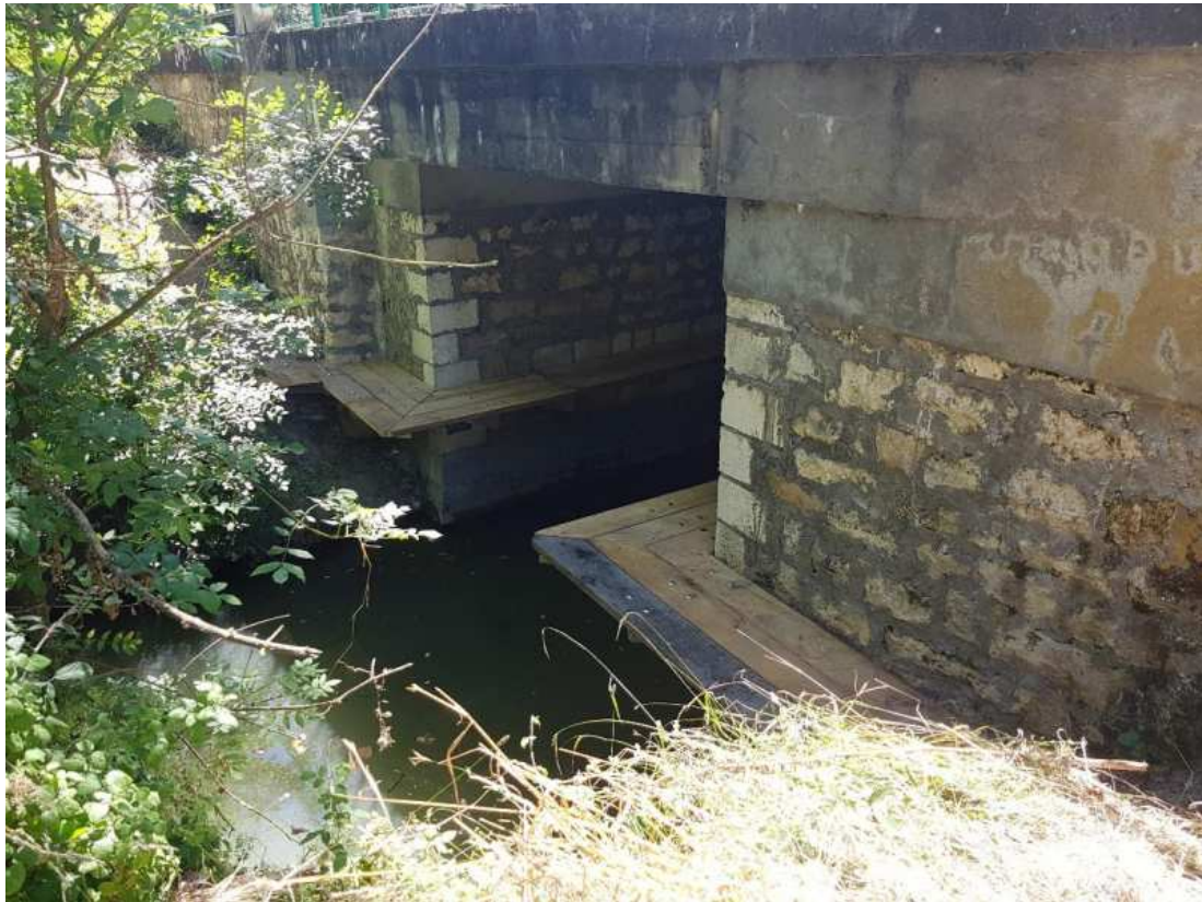
Figure 18:vue des encorbellements depuis l'amont de l'ouvrage 54b
