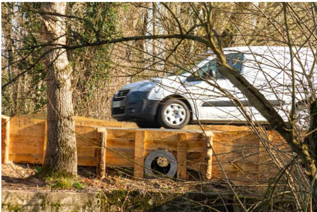
Figure 20:vue de la buse vis à vis du risque de collision routière
