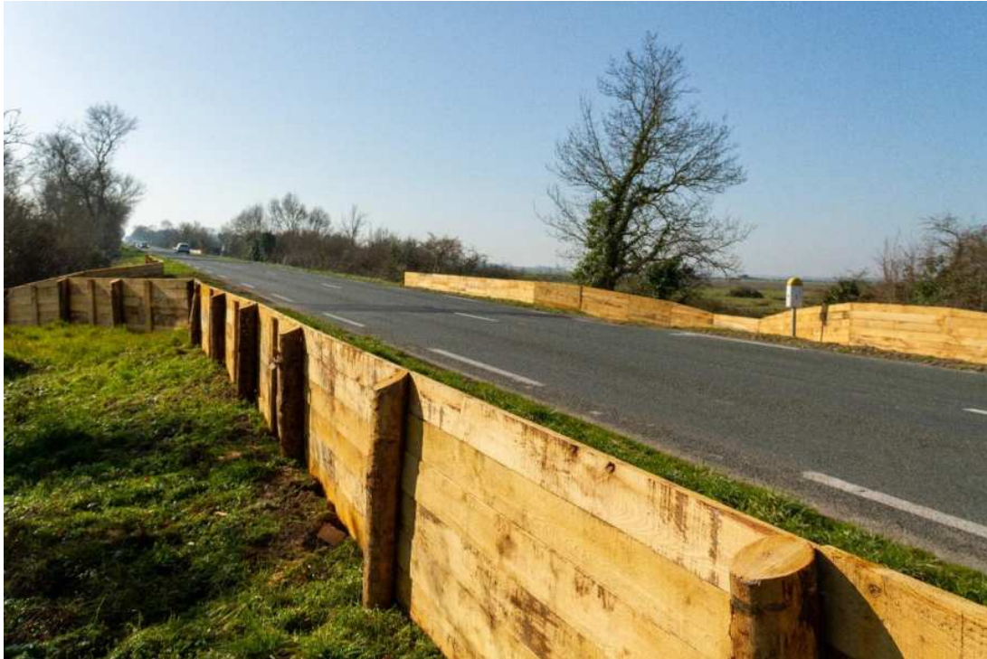
Figure 11: vue du franchissement depuis le nord-est
