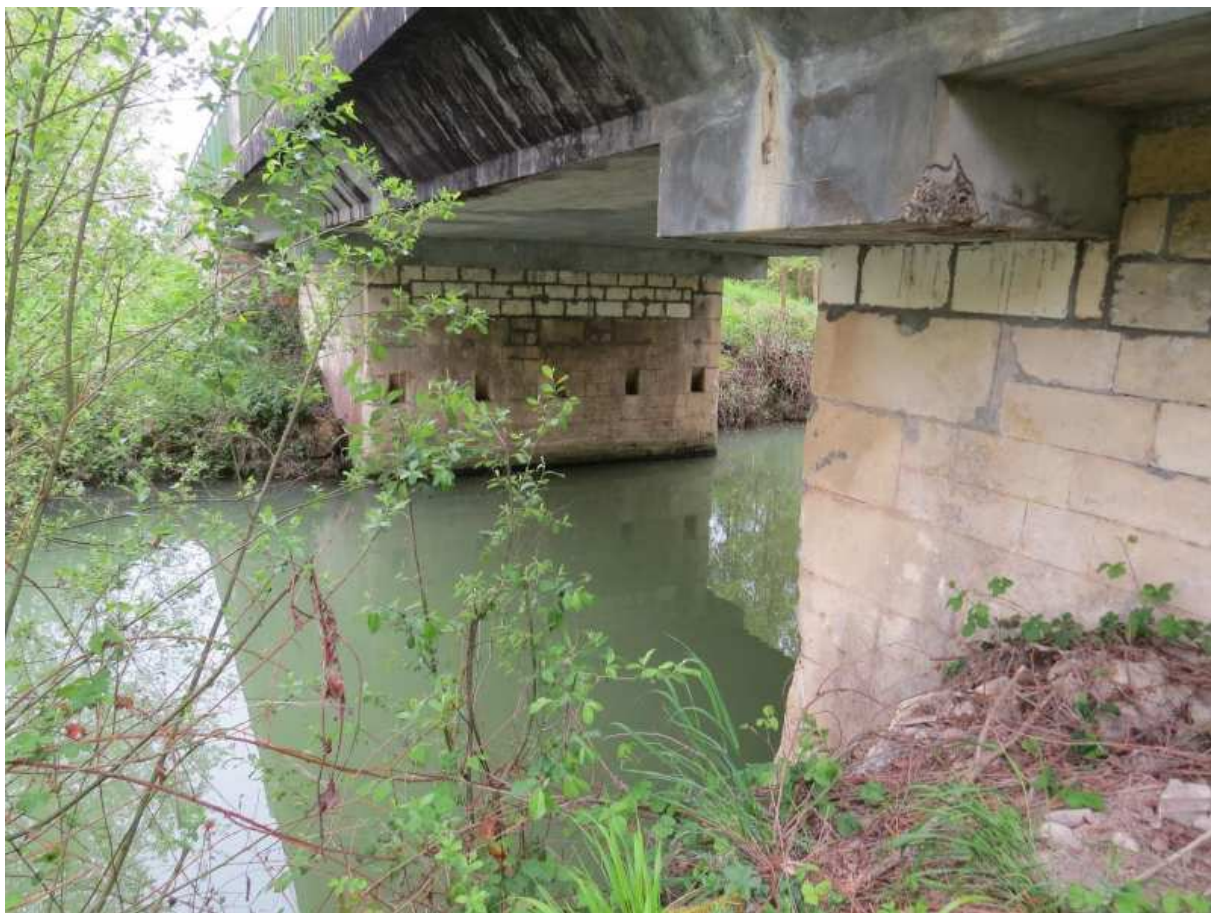
Figure 2:vue de l'ouvrage 54a
