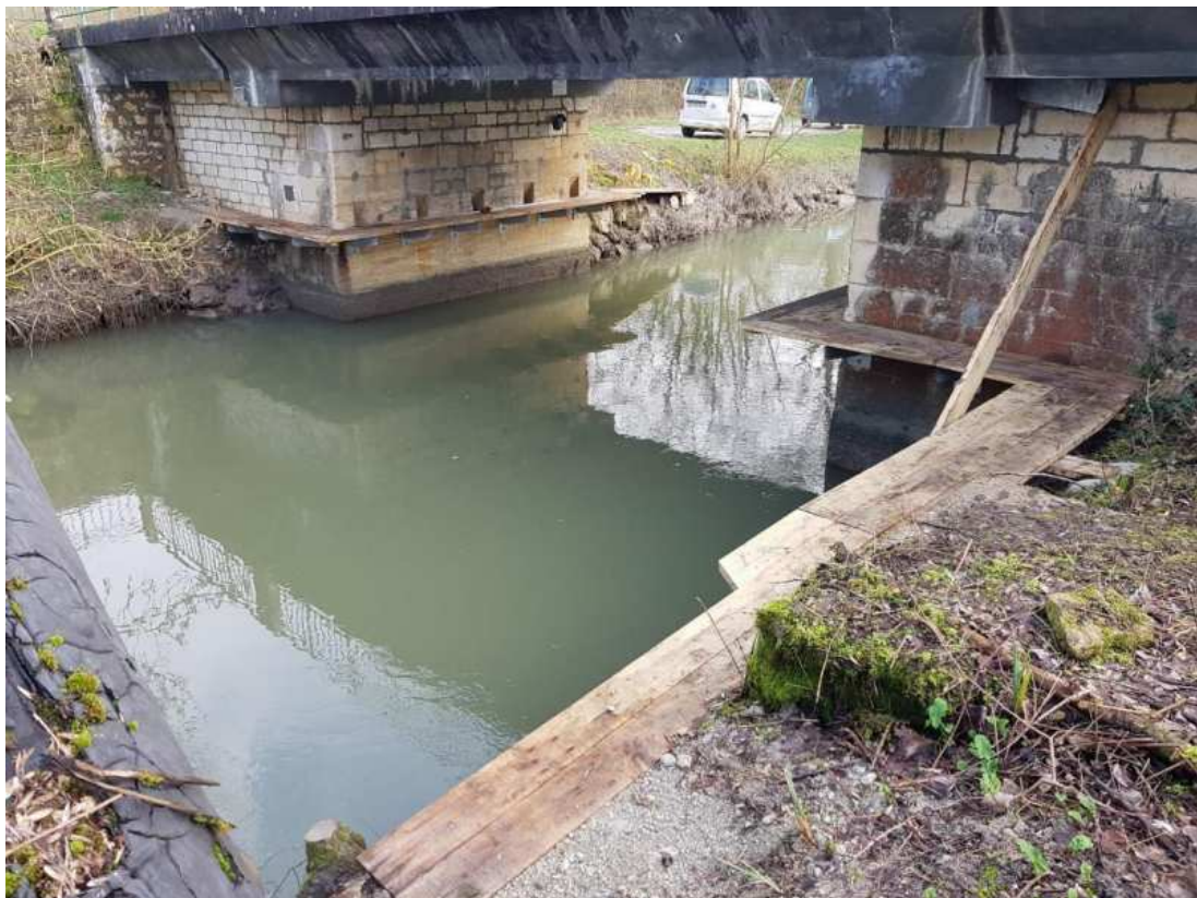
Figure 15:vue des encorbellements depuis l'aval de l'ouvrage 54b
