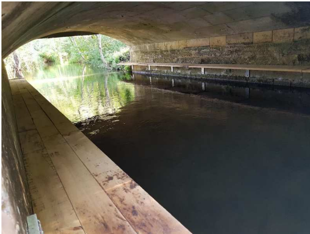
Figure 13:vue des encorbellements depuis l'intérieur de l'ouvrage 52
