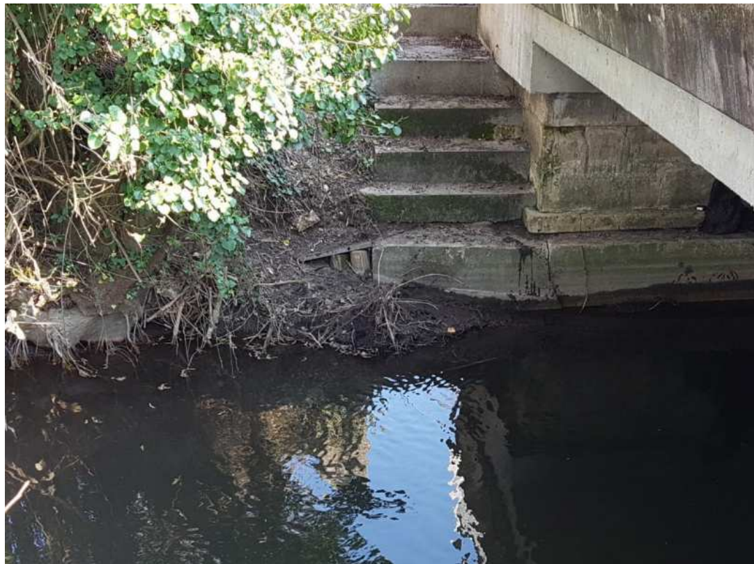
Figure 16:vue de raccord en aval de l'ouvrage 51 rive droite
