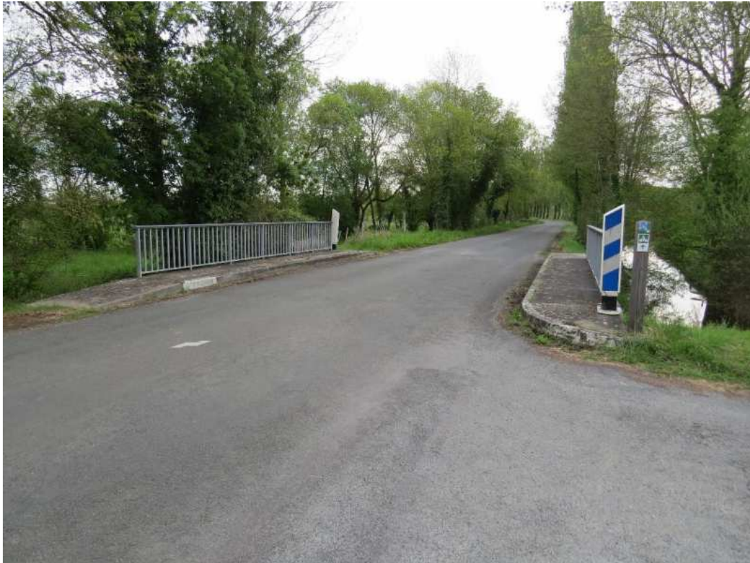
Figure 3:vue du franchissement 51 depuis l'ouest
