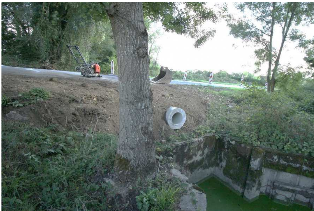
Figure 16: vue de la sortie sud-ouest de la buse sèche du canal de ceinture
