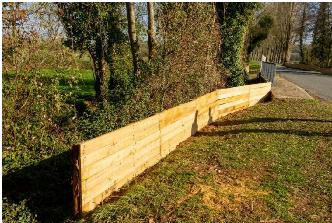
Figure 18:vue des palissades installées en aval de l'ouvrage 51 rive gauche
