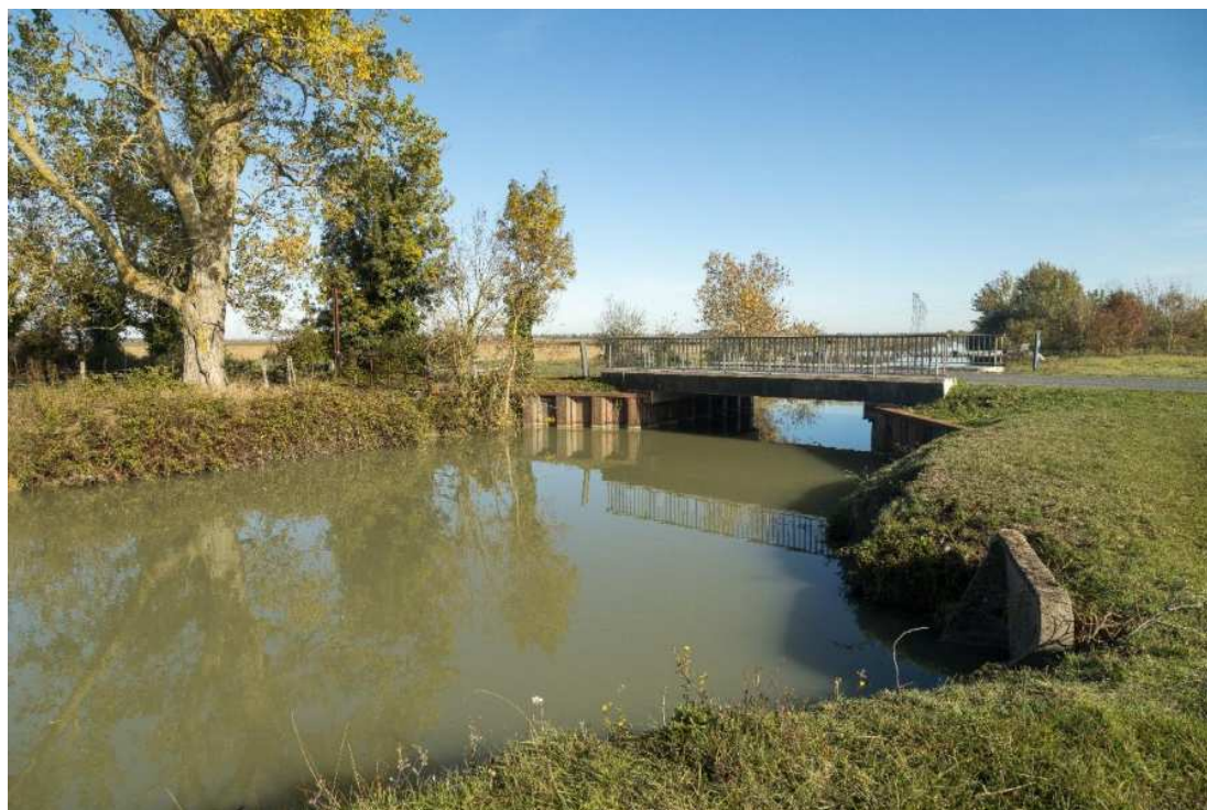
Figure 5:vue de l'ouvrage 58 depuis l'aval
