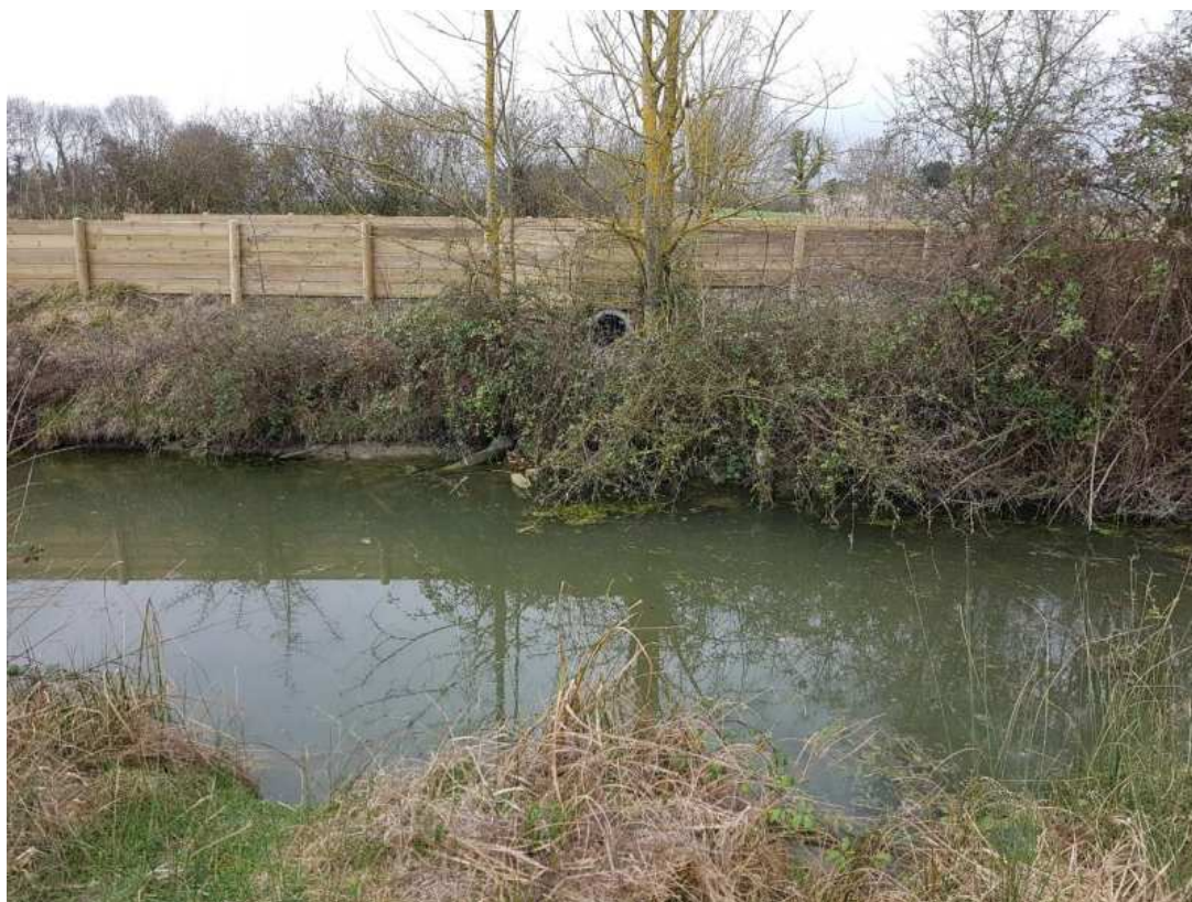
Figure 16: vue de la buse depuis le canal des Treize prises
