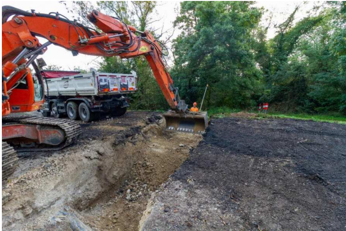
Figure 7: creusement de tranchée
