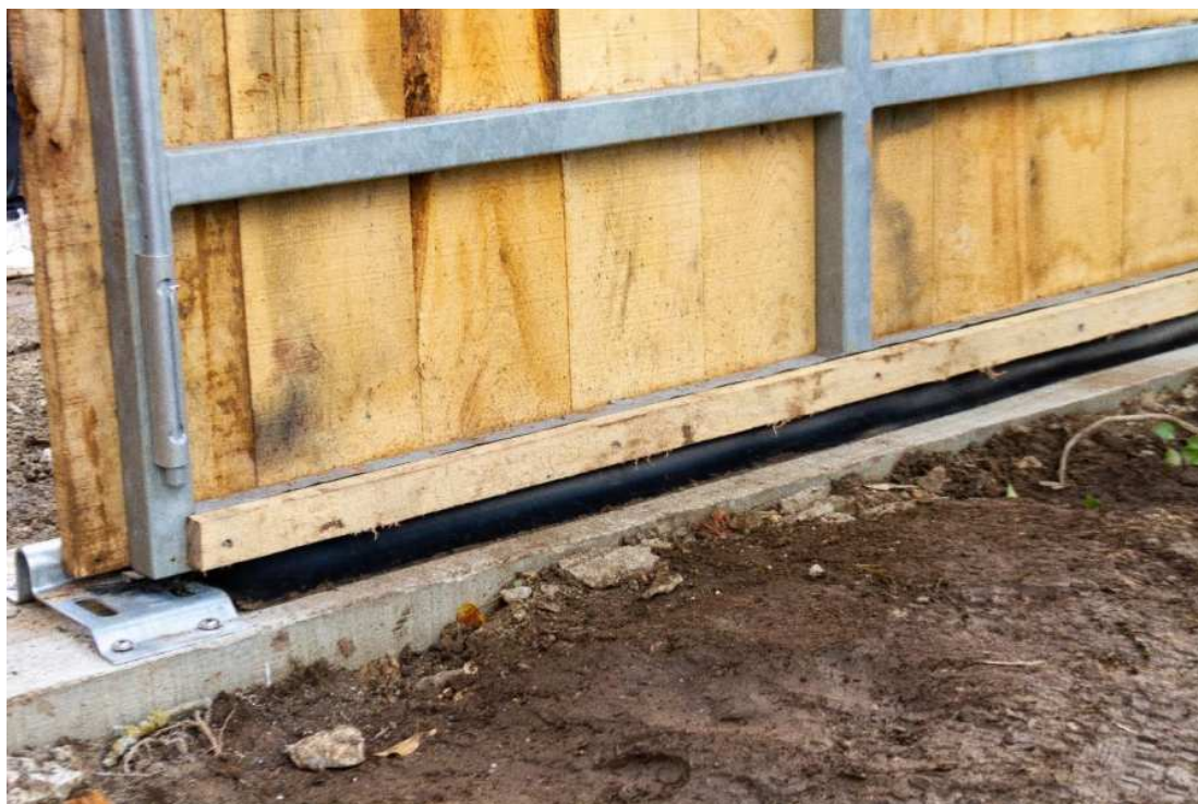
Figure 27: réglage des vantaux et des bavettes
