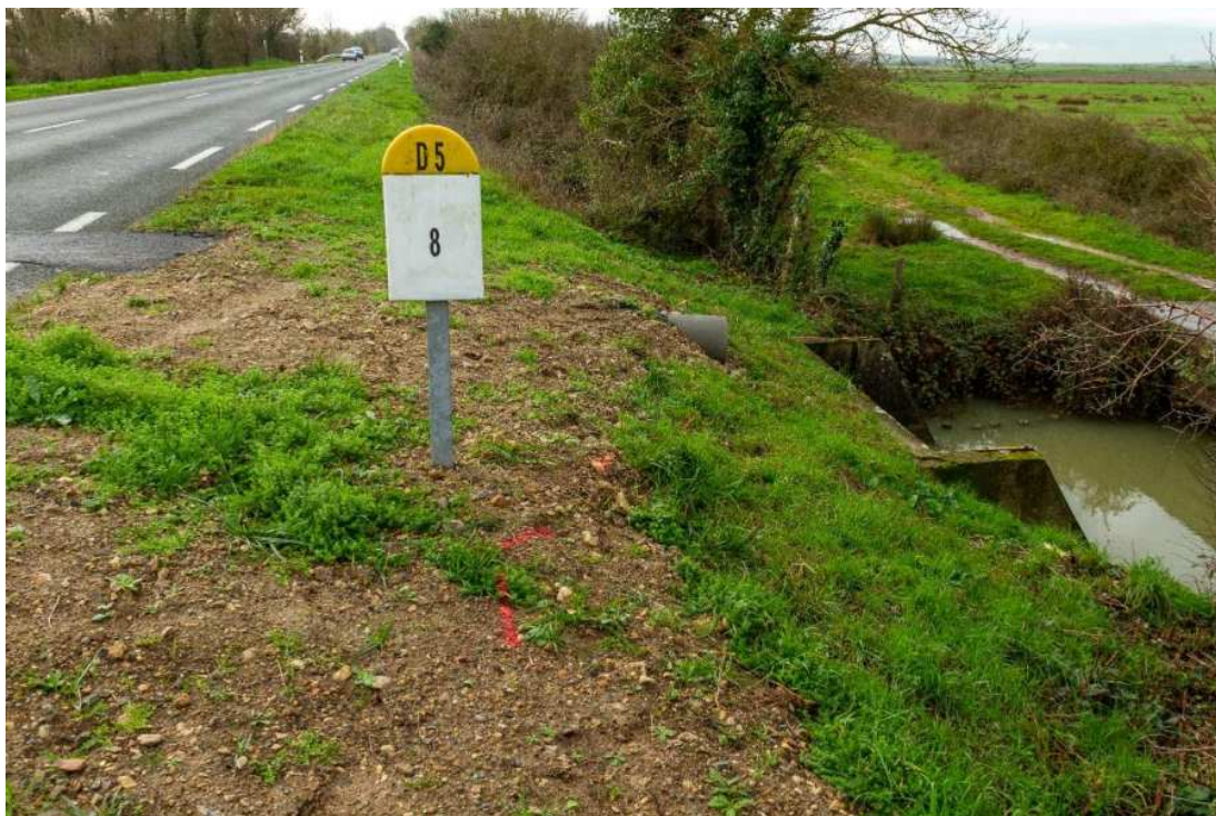
Figure 9: vue de la sortie de buse côté ouest
