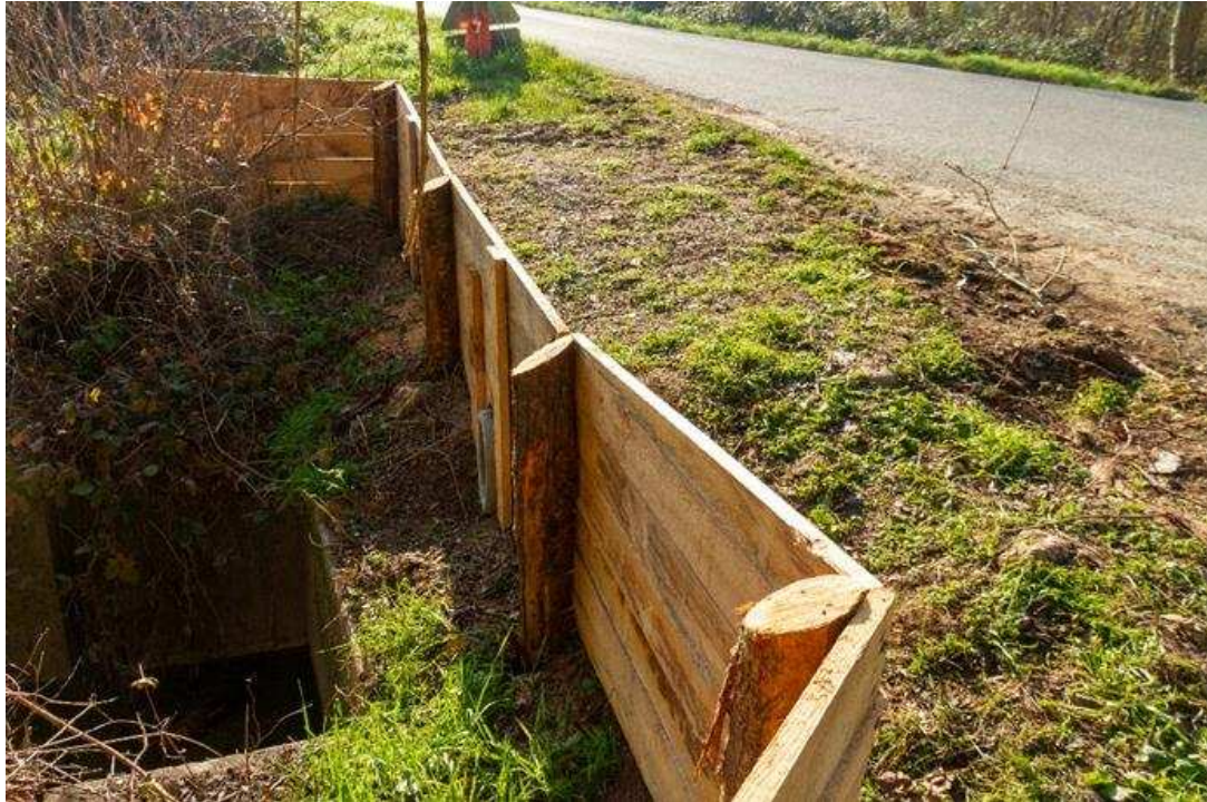
Figure 18:vue de la palissade nord du canal de ceinture
