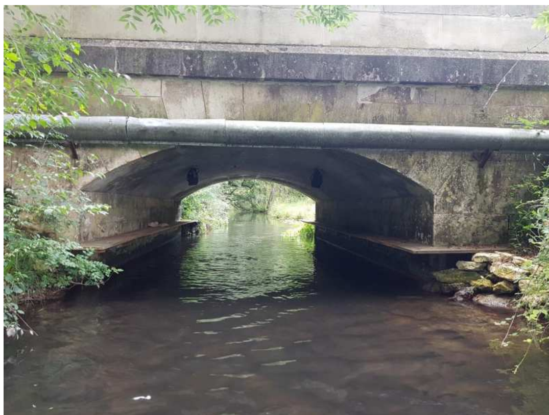
Figure 12:vue des encorbellements depuis l'aval de l'ouvrage 52
