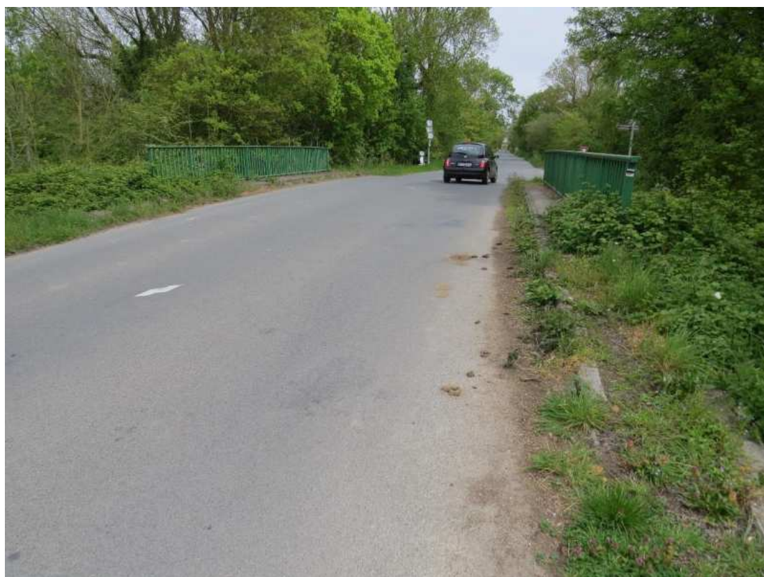
Figure 3:vue du franchissement depuis l'ouest
