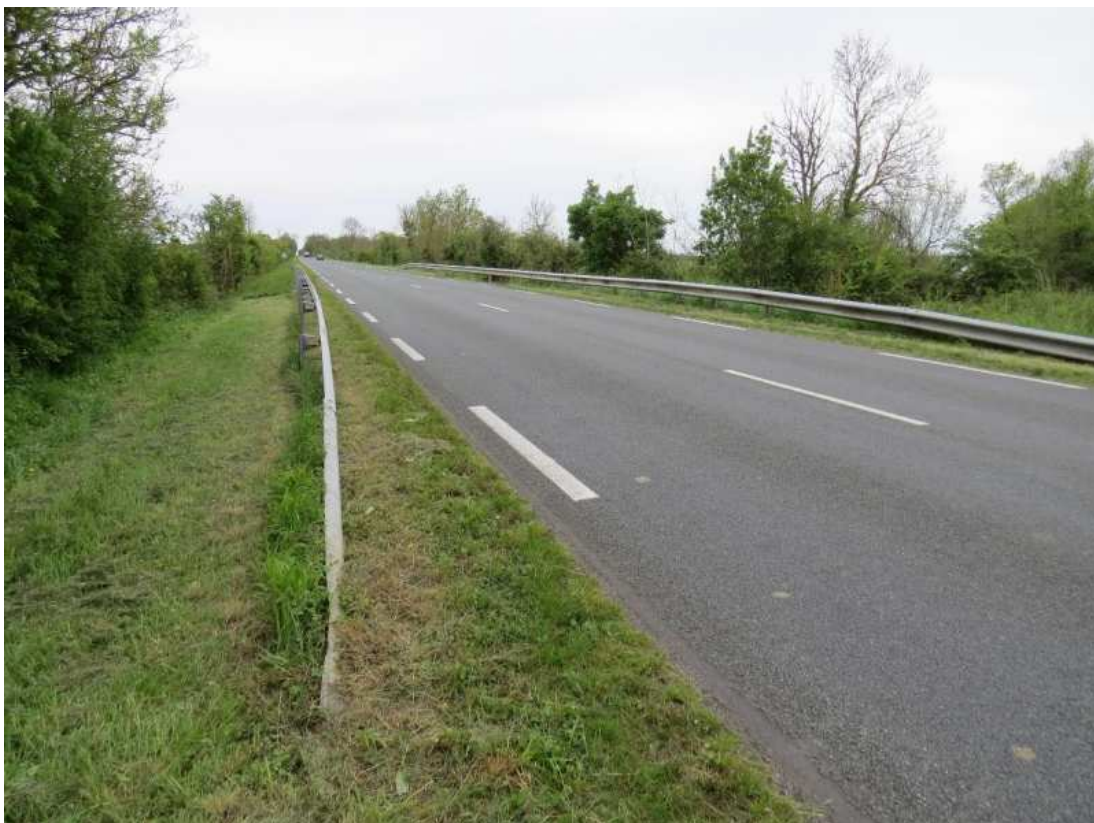
Figure 3:vue du franchissement depuis le nord
