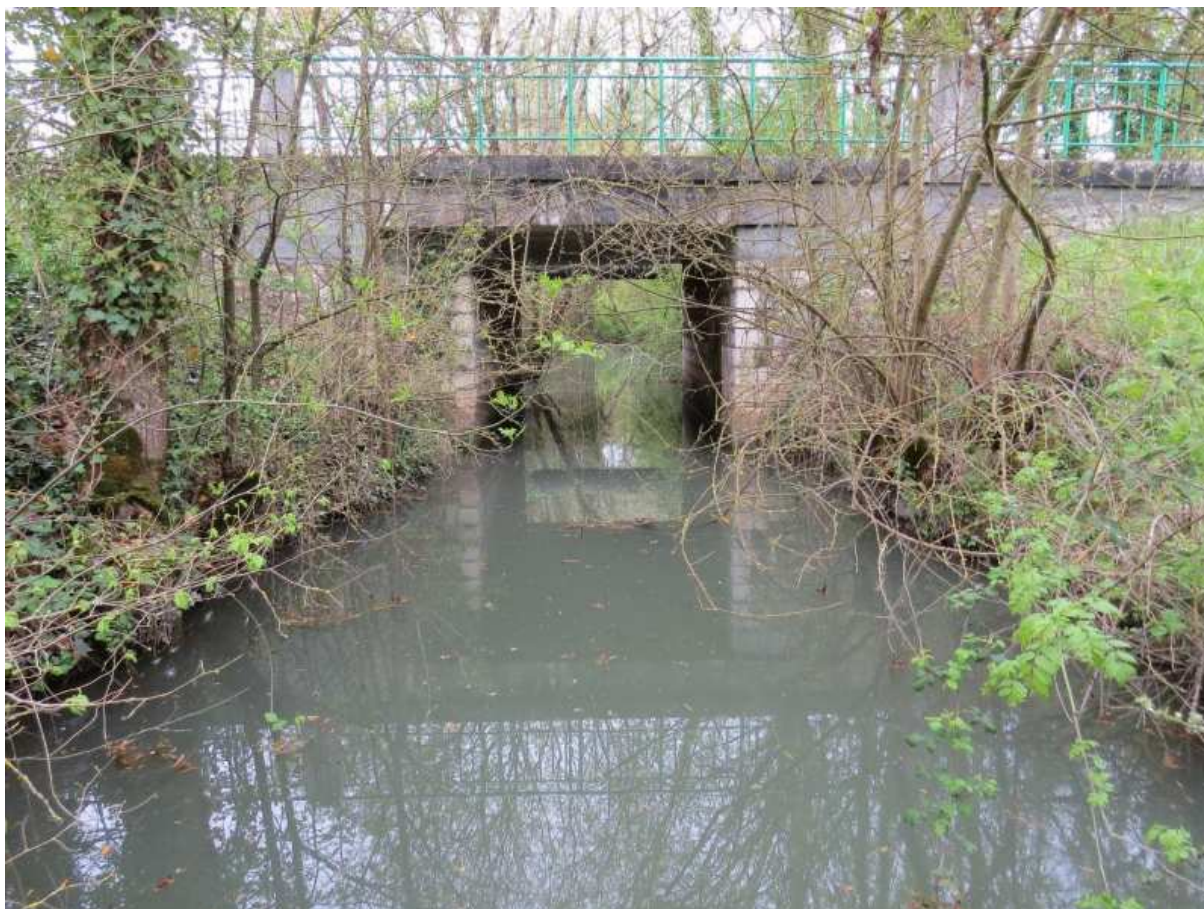
Figure 3:vue de l'ouvrage 54b
