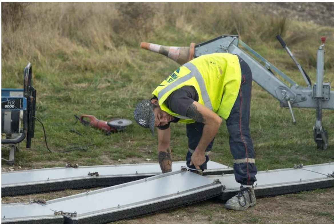
Figure 12: assemblage des pontons
