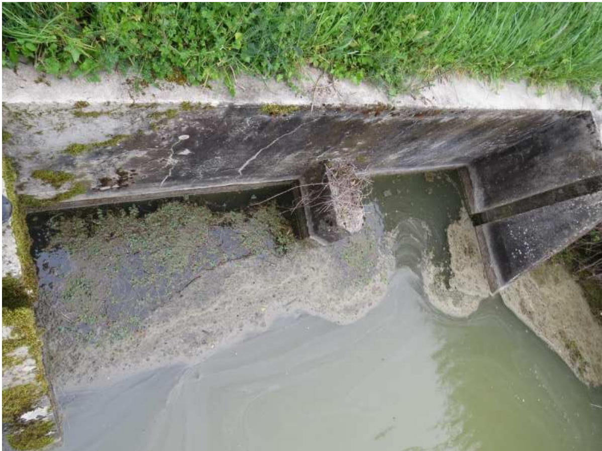
Figure 2:vue de l'ouvrage immergé 55
