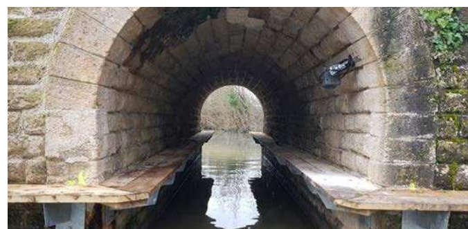
Encorbellements dans un ouvrage du marais de Rochefort © LPO/LIFE VISON
