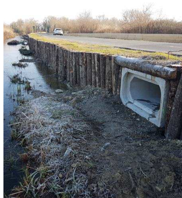
Dalot spécifique mis en place sur le linéaire du marais de Voutron © LPO/LIFE VISON
