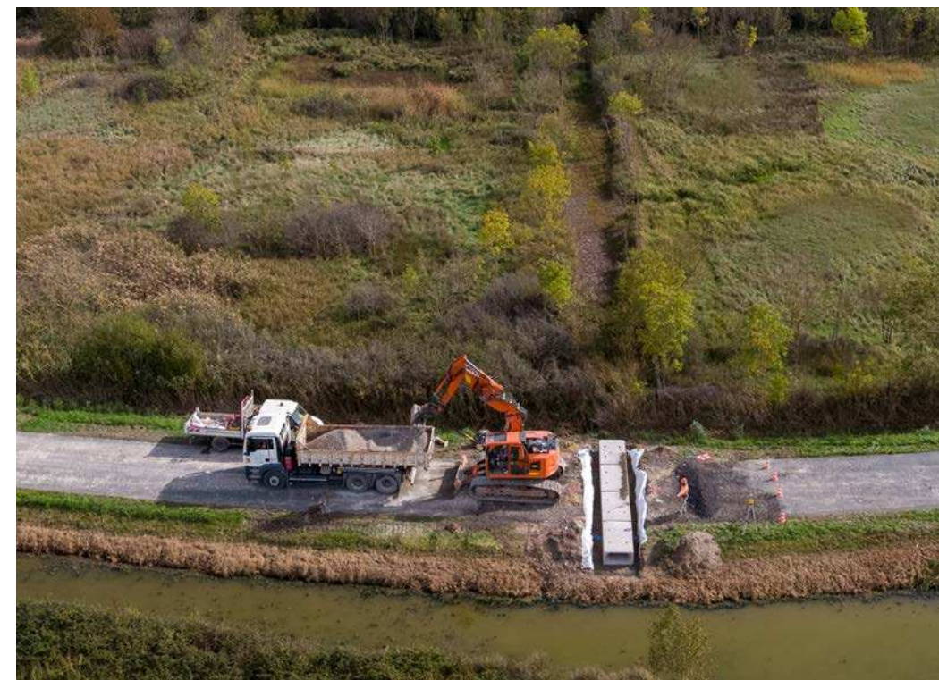
Vue aérienne de la mise en place des dalots sur le linéaire du marais de Voutron © Beaubert R./LPO/LIFE VISON
