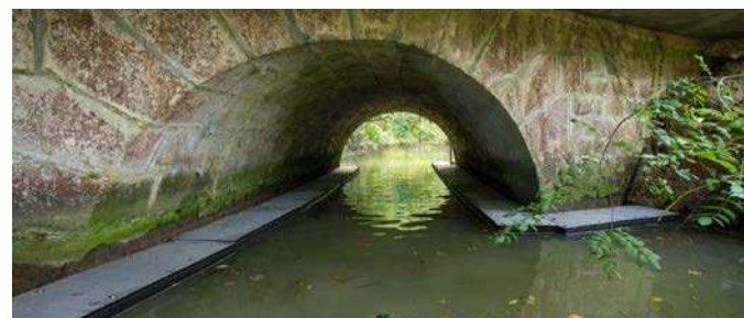
Pontons flottants dans un ouvrage dans les marais de Rochefort © LPO/LIFE VISON
