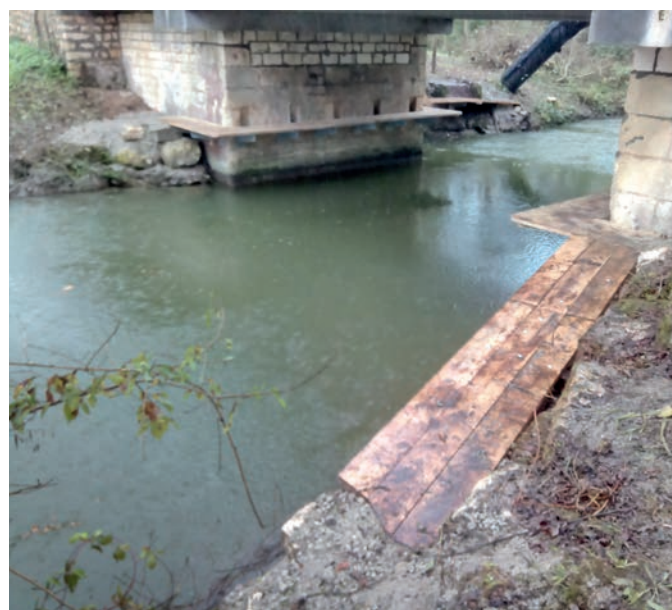
Encorbellement réalisé sur un ouvrage à Ciré-d'Aunis (avant travaux à gauche et après travaux à droite) © R.Beaubert / LPO / LIFEVISON
